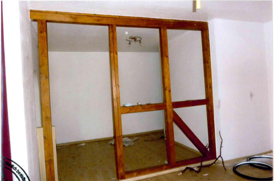
Bild 79 und 80 Der von der Diele durch eine offene Fachwerkwand abgetrennte Raum 1
