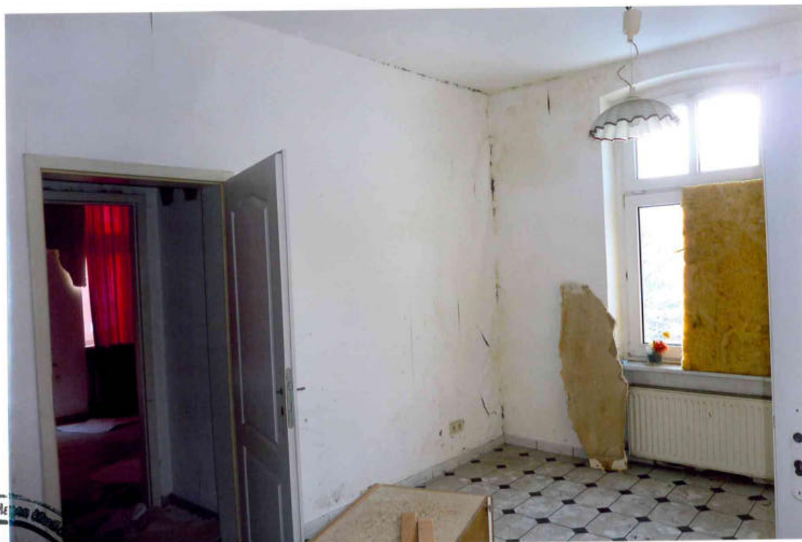
Bild 69 und 70 Küche, welche auch als Durchgangsraum zu Raum 2 dient.
