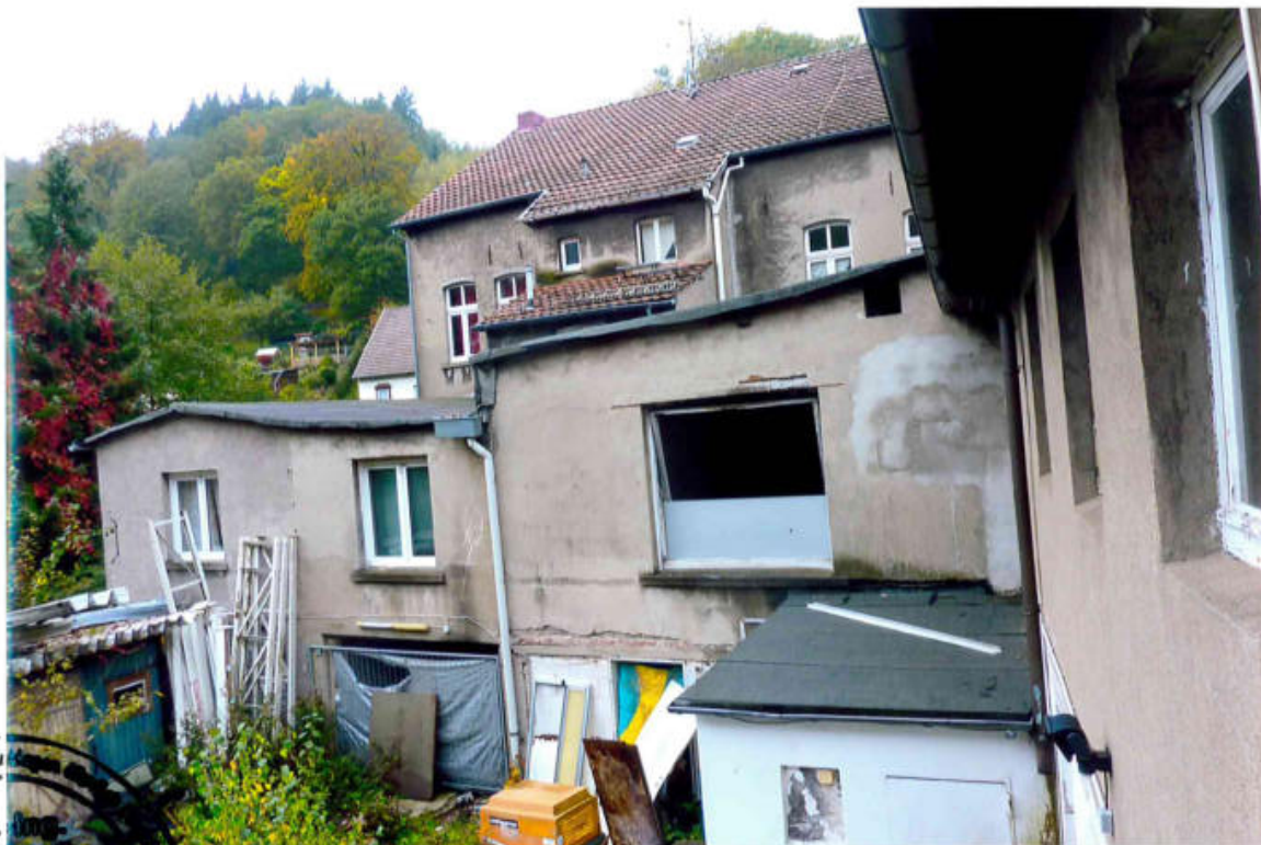
Bild 13 und 14 Blick vom Obergeschoss des Gebäudeteils III auf die zum Osten orientierten Rückansichten der Gebäudeteile I, II und IV
