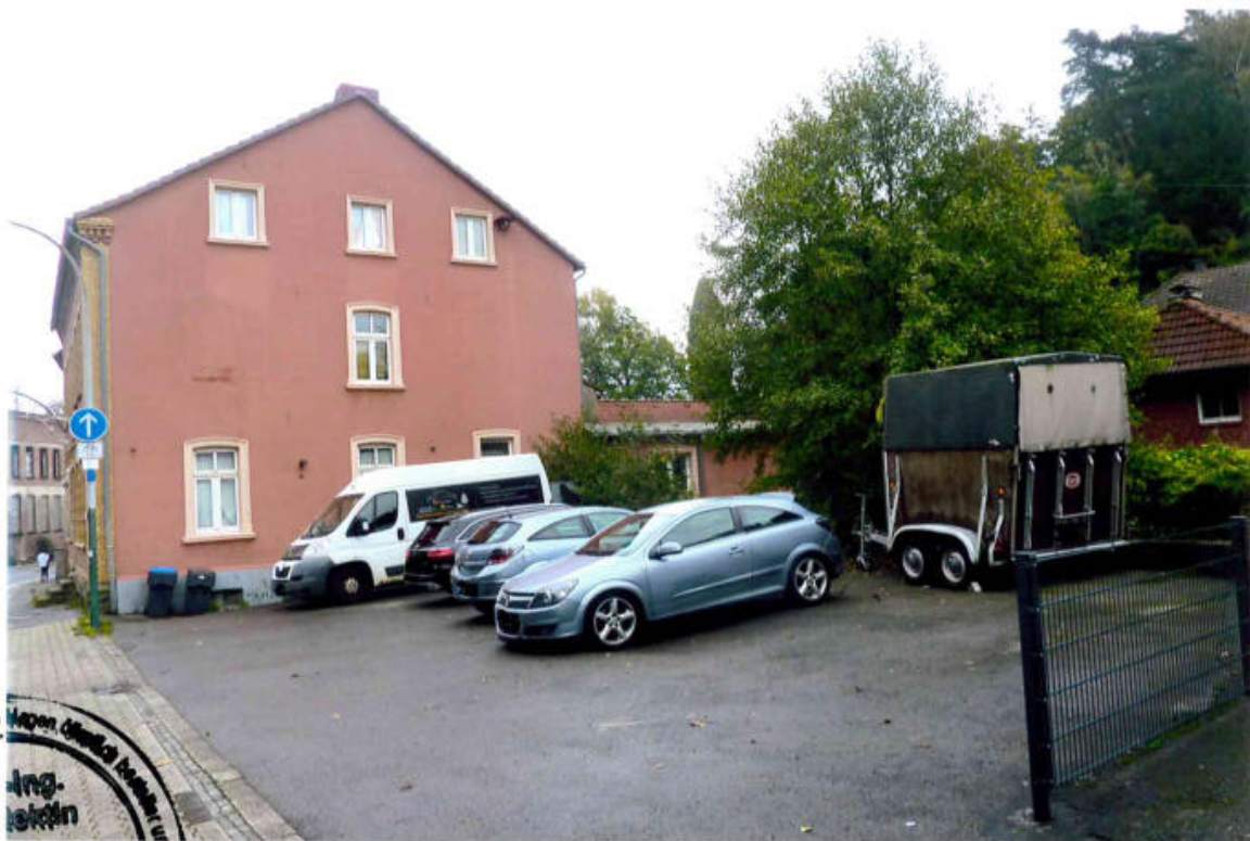
Bild 3 und 4 Zum Süden orientierte Giebelfassade des Haupthauses (I) mit vorgelagertem, als „Platz“ bezeichnetem Kfz-Stellplatzgrundstück sowie Blick von dort auf die ebenfalls zum Süden orientierte Ansicht des rückseitig gelegenen Anbaus (II)
