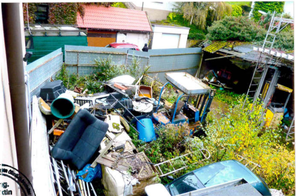
Bild 19 und 20 Blick vom Obergeschoss des Gebäudeteils III auf das mit V bezeichnete, nahezu parallel der südlichen Grundstücksgrenze gelegene Überdachungsbauwerk
