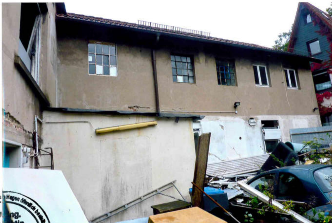
Bild 17 und 18 Blick vom Hof auf die zum Süden orientierte Ansicht des Gebäude- teils III
