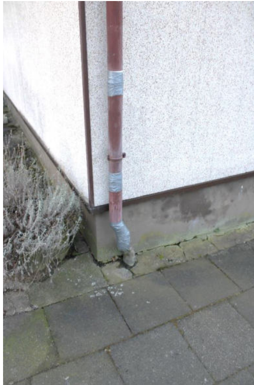
Bild 9: Detailfoto - leichte Wärmedämmmaßnahmen
