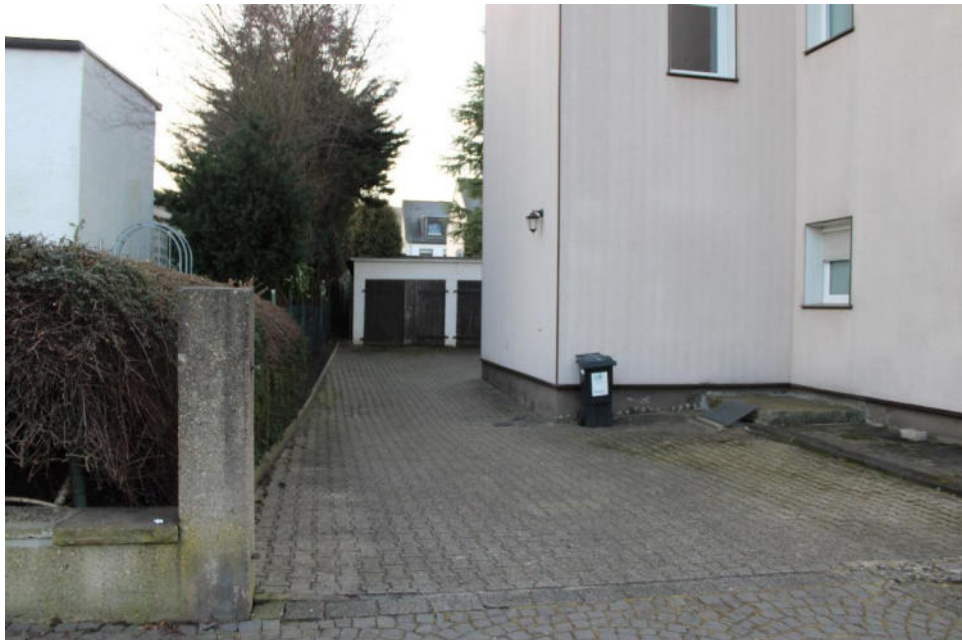
Bild 8: Zuwegung zum rückseitigen Hauseingang und Zufahrt zu den Garagen
