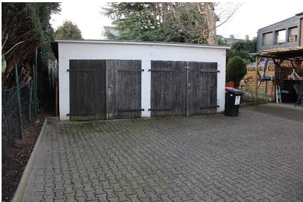
Bild 10: Nordansicht der Garagen / Hoffläche
