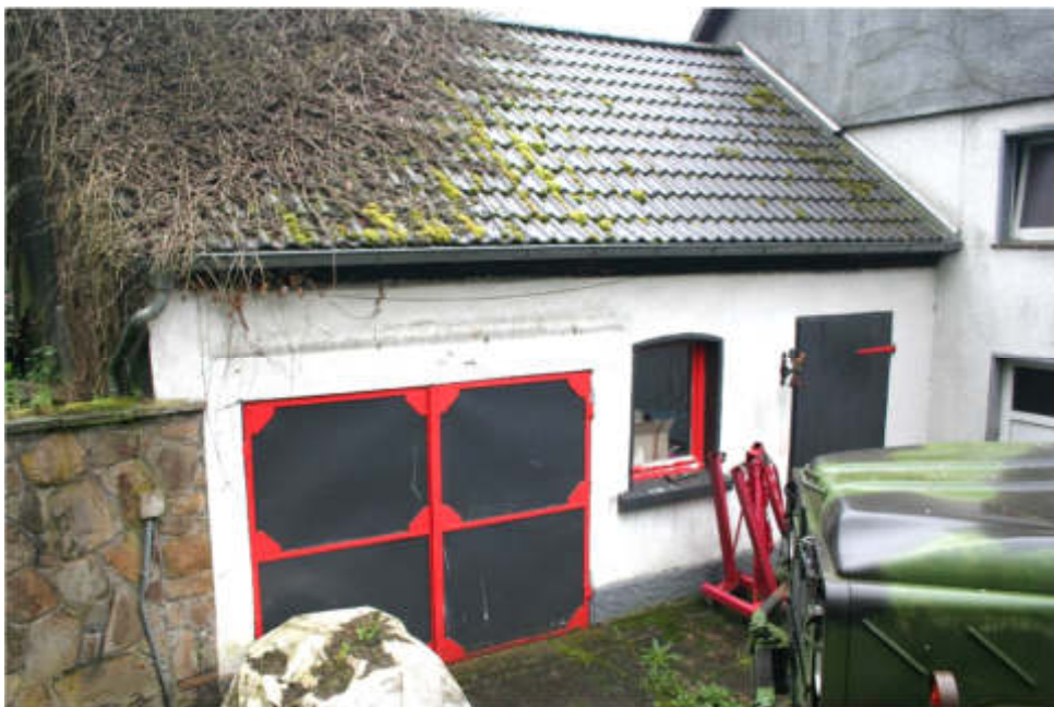
Bild 6: 1-geschossiger Anbau Werkstatt / Garage / Westansicht
