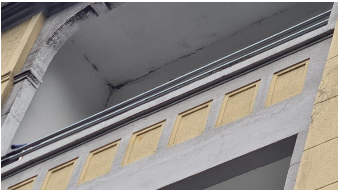
Bild 8: Detailfoto Feuchtigkeitseinwirkungen Balkon zur Eugen-Richter-Straße
