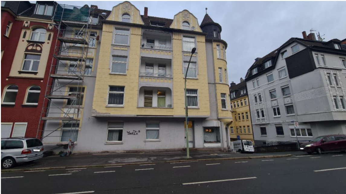
Bild 7: Straßenansicht Eugen-Richter-Straße / Südansicht
