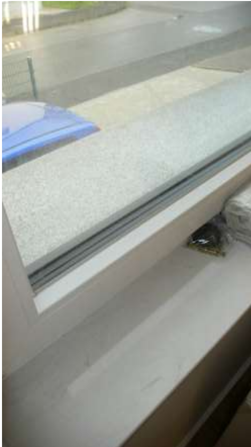
Bild 31: Fensterdetail im EG
