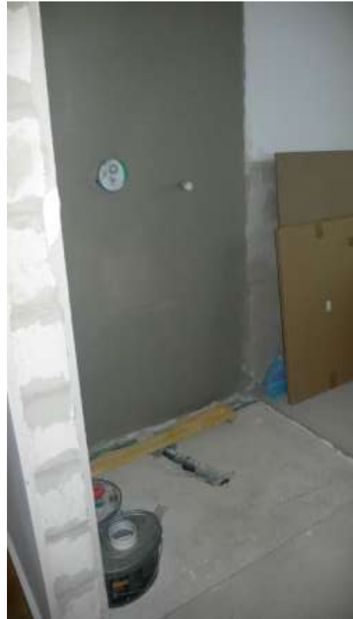
Bild 27 + 28: Badinstallationen im EG
