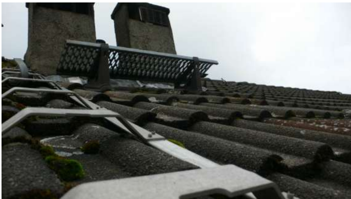
Bild 66: Dachfläche und Kaminköpfe
