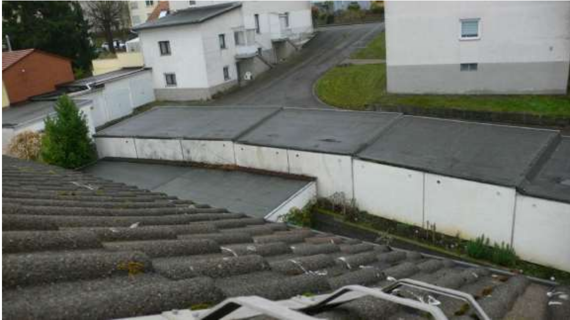
Bild 5: Blick nach Süden
