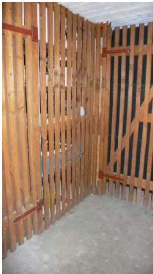
Bild 20: Kellerflur und Türen
