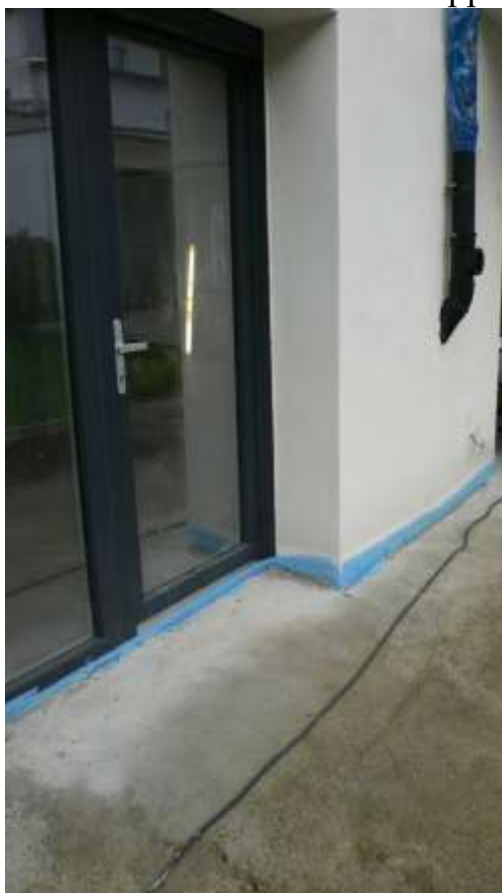
Bild 13: Terrassentür im EG
