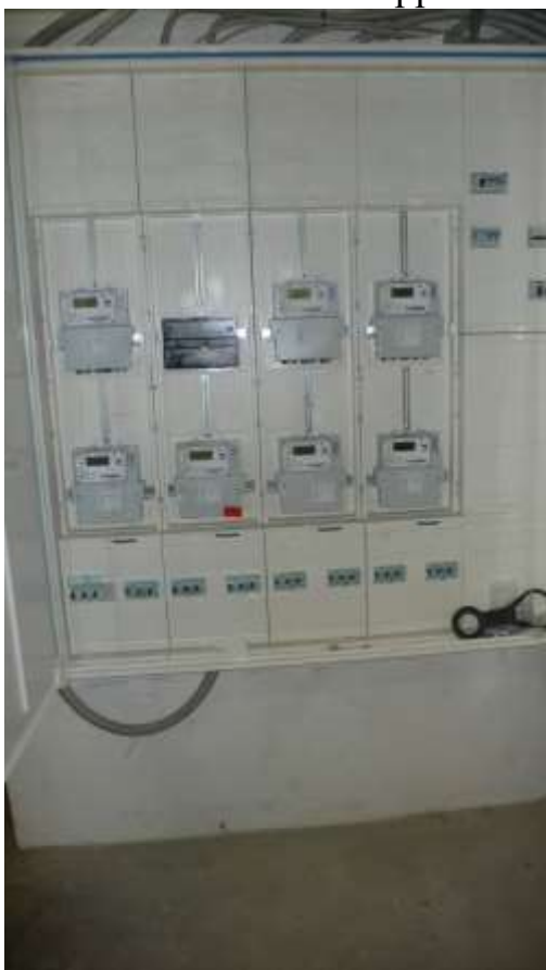
Bild 19: Haustechnik, Stromzähler
