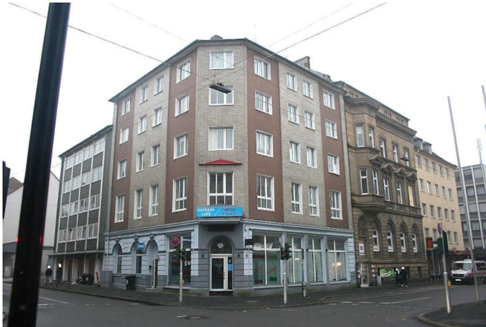
Bild 3: Straßenansicht / Südostansicht Hindenburgstraße und Nordostansicht Bahnhofstraße
