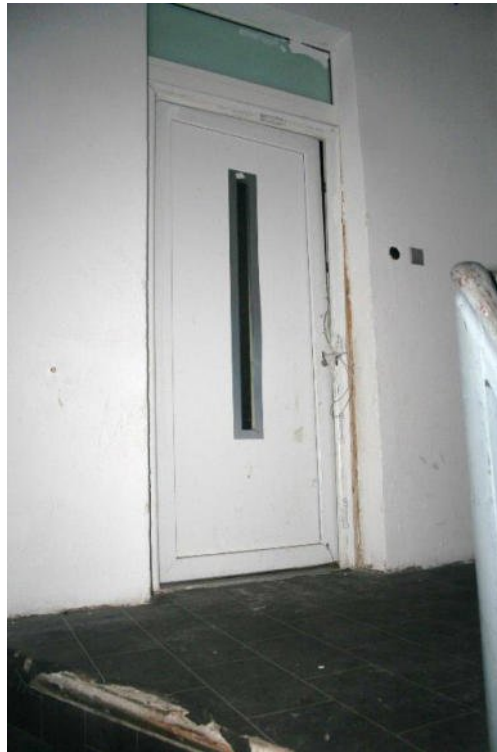
Bild 17: Wohnungszugangstür Wohnung 1. Obergeschoss, Nr. 3 des Aufteilungsplans
