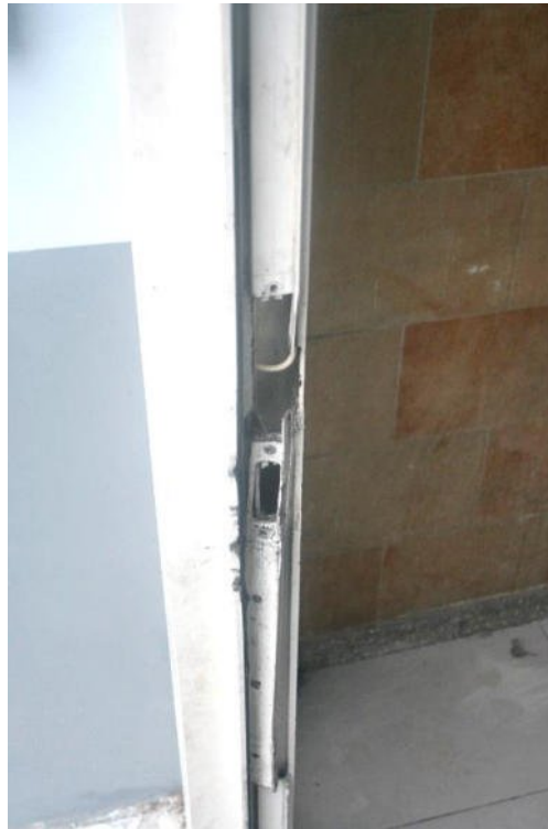
Bild 13: Hauseingang (defektes Schließblech)
