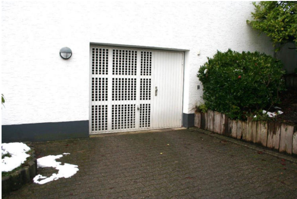
Bild 7: Zufahrt Tiefgarage (Flurstück 512)
