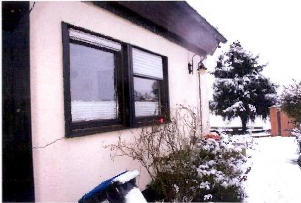
Bild 5: Südwestansicht des Gebäudes / Teilfläche des rückseitigen Gartens
