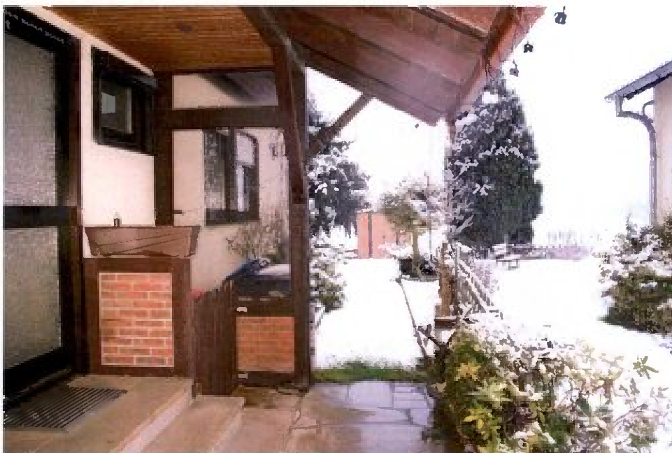
Bild 4: Hauseingang / Südwestansicht des Gebäudes
