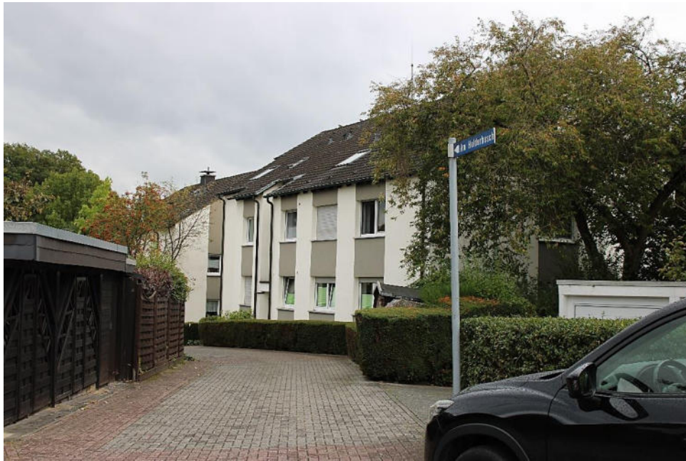
Bild 1: Umgebungsbebauung Richtung Osten
