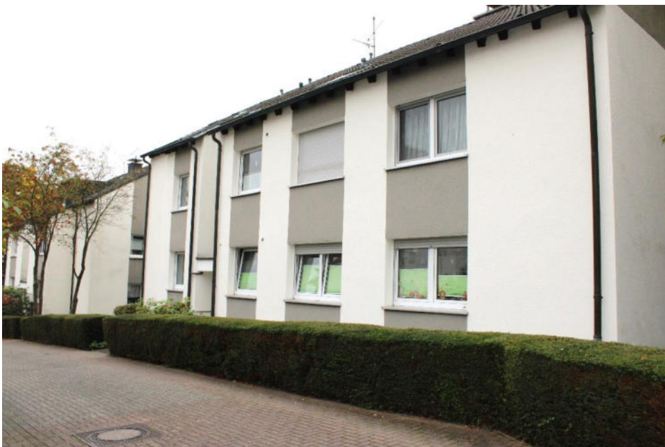
Bild 4: Straßenansicht Am Holderbusch 20 / Nordansicht
