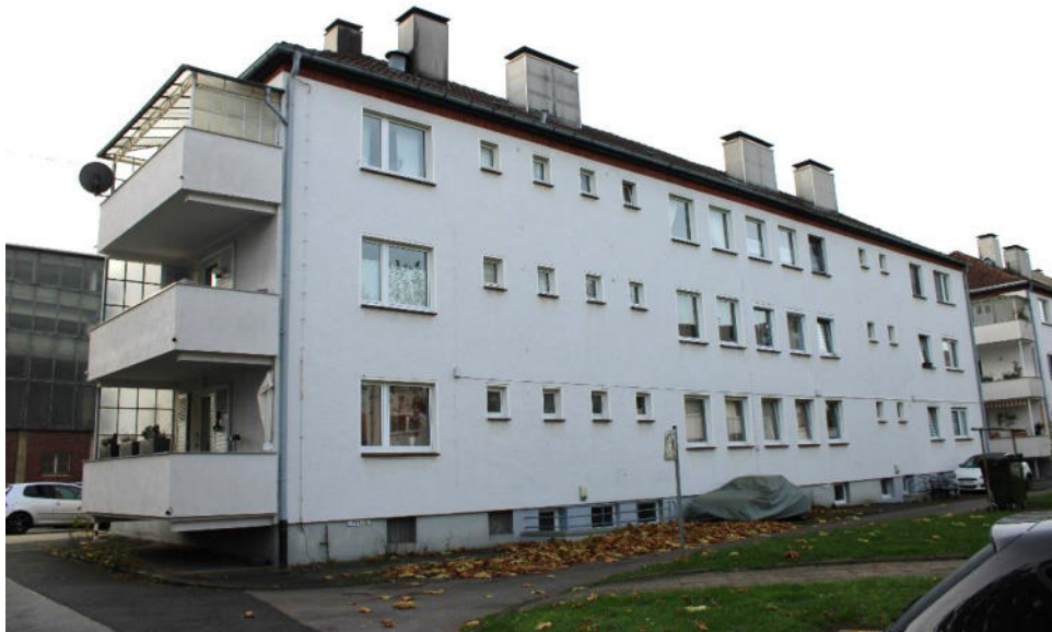
Bild 8: Nordostansicht und Rückansicht / Nordwestansicht Gebäude 160 und 162
