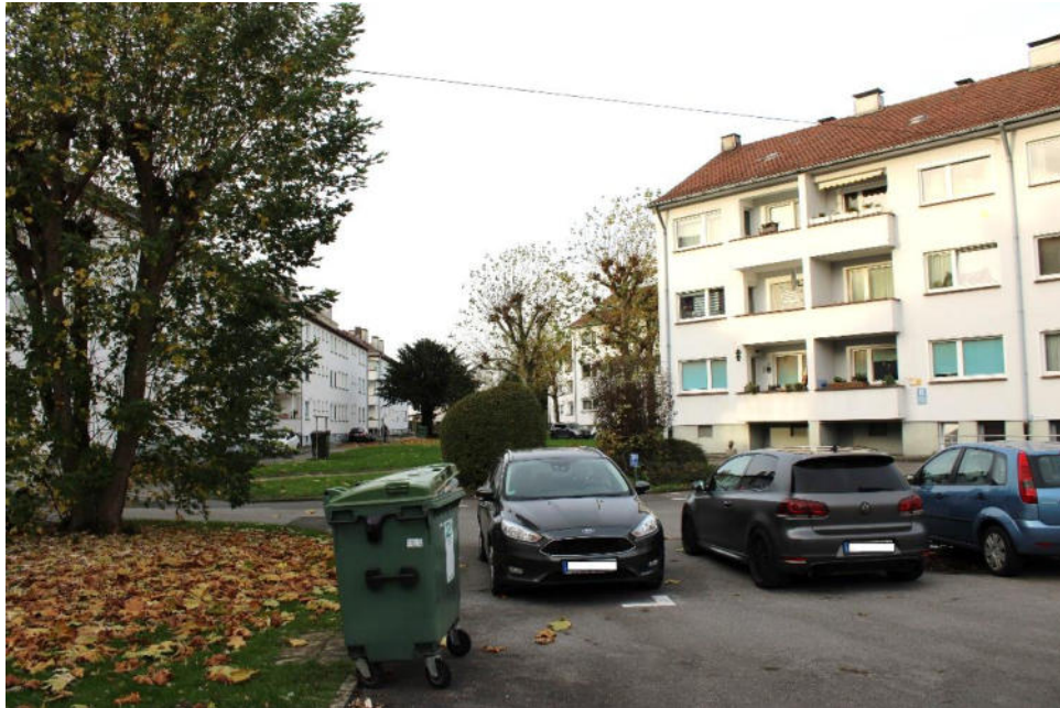
Bild 11: Kfz-Stellplatzflächen auf dem Grundstück (SNR) / Südostansicht Gebäude 162a
