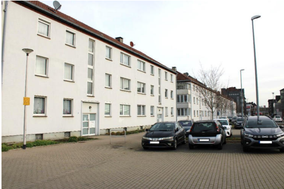
Bild 3: Straßenansicht Häuser Enneper Str. 160 bis 170 / Südostansicht
