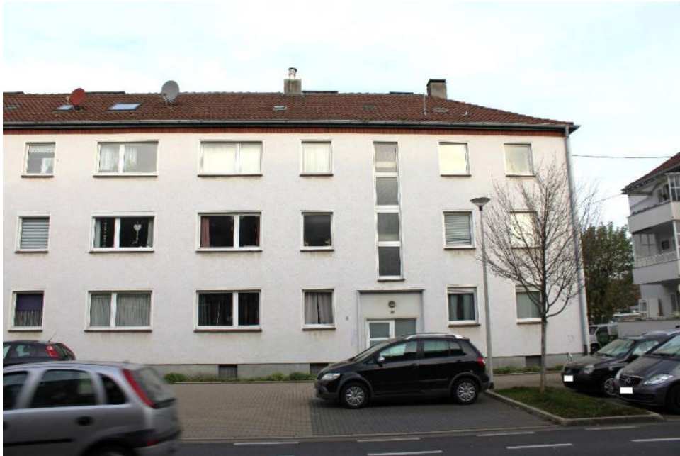
Bild 5: Straßenansicht Enneper Str. 160 / Südostansicht
