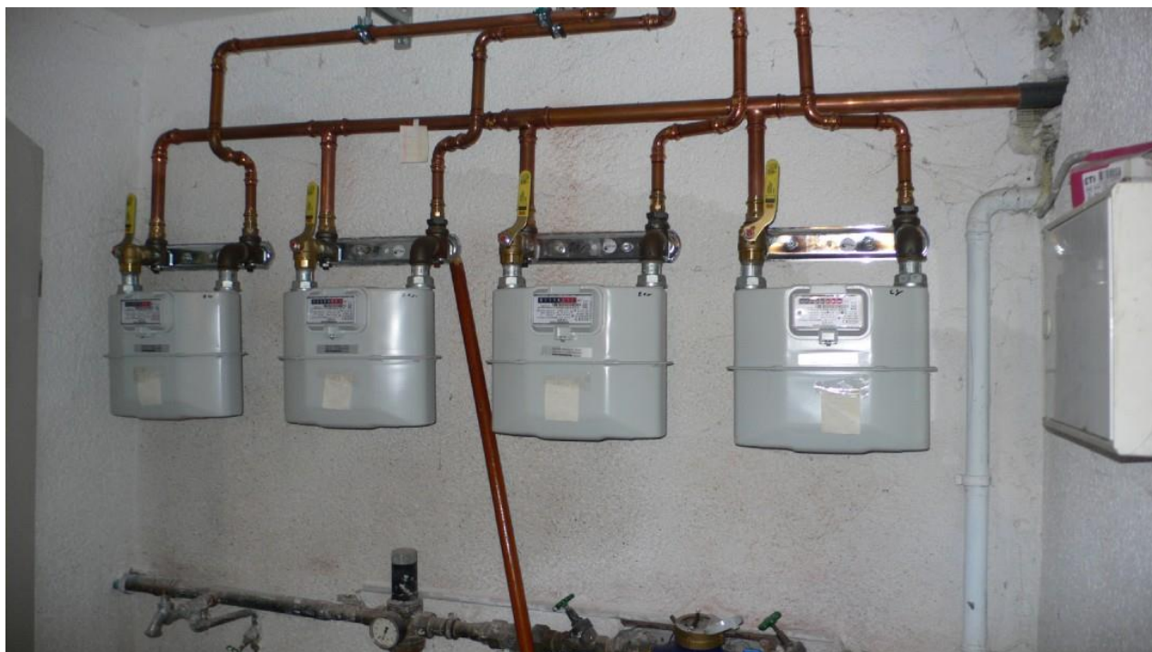
Bild 24: Gaszähleranlage im Keller
