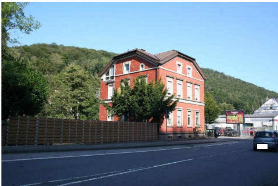
Bild 4: Straßenansicht / Südansicht und Ostansicht
