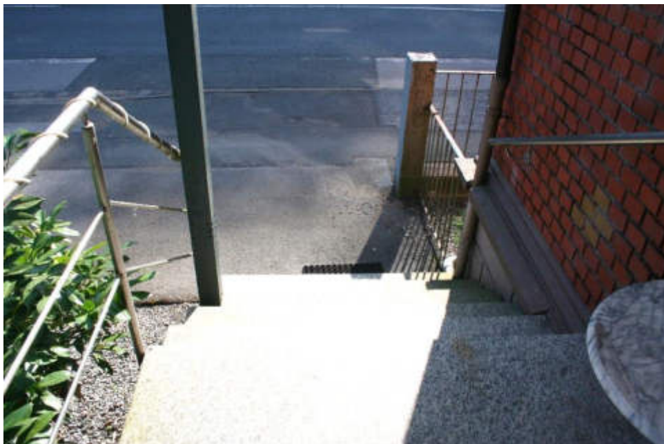
Bild 8: Eingangstreppe Wohnung Nr. 3
