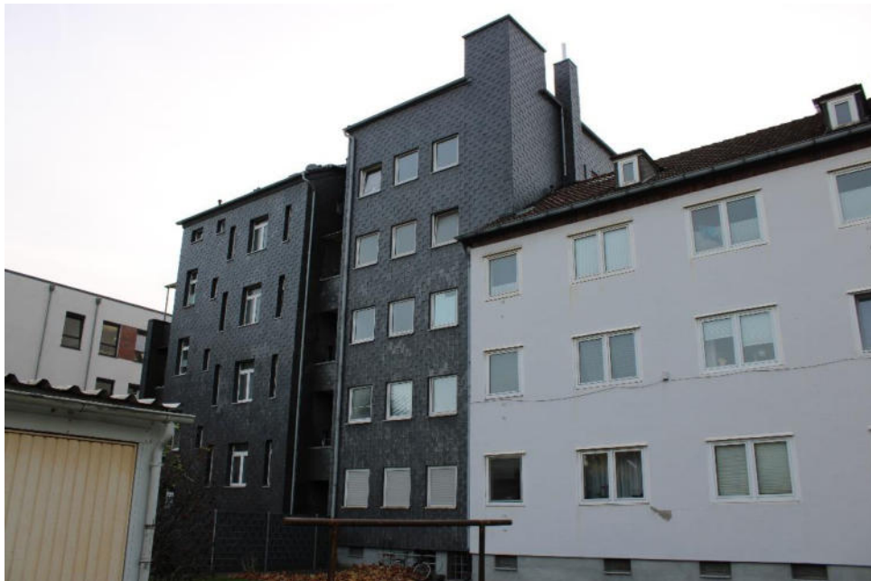
Bild 8: Rückansicht / Nordwestansicht Gebäude 154 und 156
