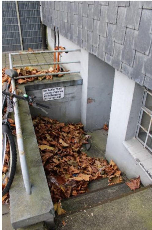
Bild 9: rückseitig gelegene Kelleraußentreppe des Gebäudes Enneper Str. 156
