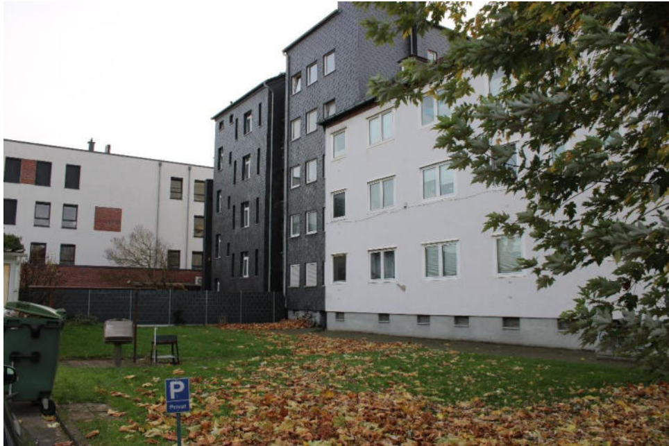
Bild 7: Rückansicht / Nordwestansicht Gebäudegruppe 154 bis 158
