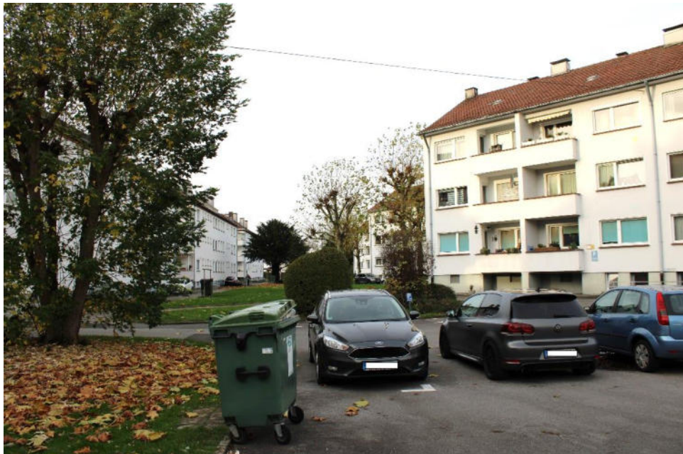
Bild 14: Stellplatzflächen auf dem Grundstück (SNR) / Südostansicht rückseitige Bebauung
