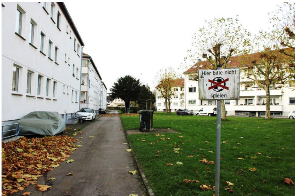
Bild 12: rückseitige Rasen- und Wegeflächen / Nordwestansicht der Straßenseitigen Bebauung Häuser 160 bis 170 und Südostansicht der rückseitigen Bebauung Häuser 166a und 170a
