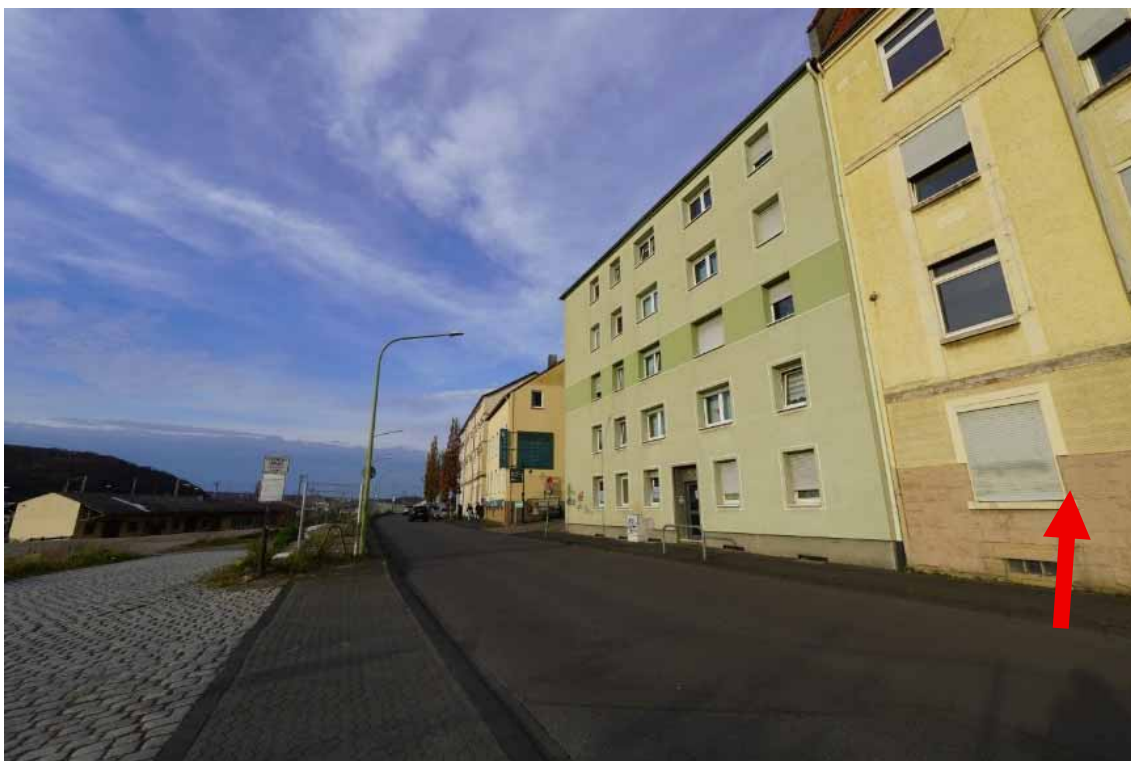
Blick Richtung Norden
