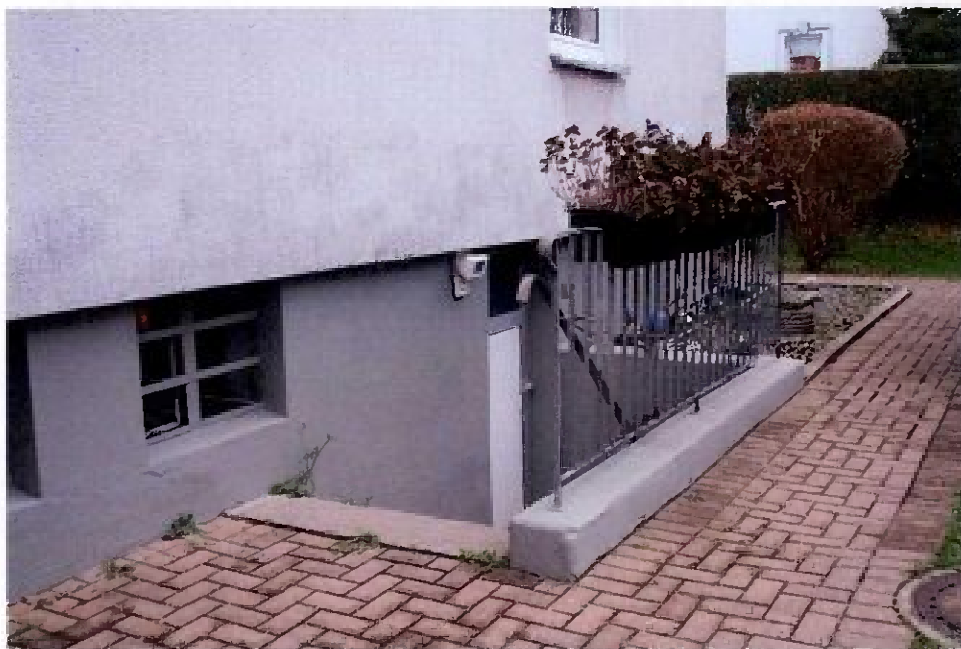
Bild 8: Kellerabgangstreppe am Südostgiebel
