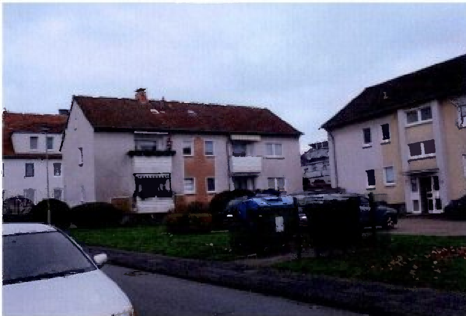
Bild 16: Rückansicht Masurenstraße 11 / Südwestansicht
