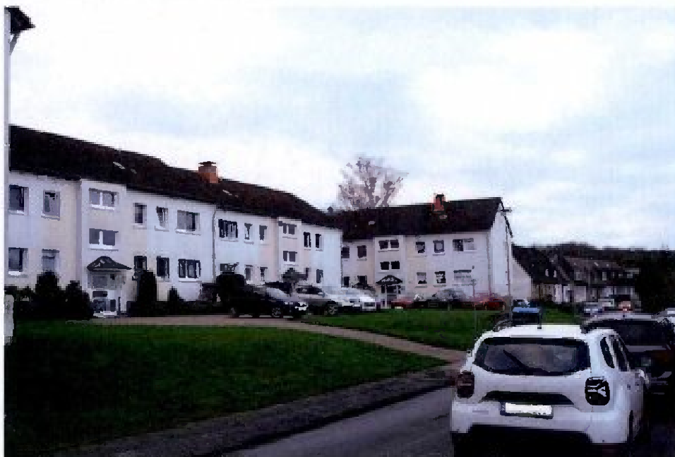
Bild 13: Straßenansicht Masurenstraße 25, 27 und 29
