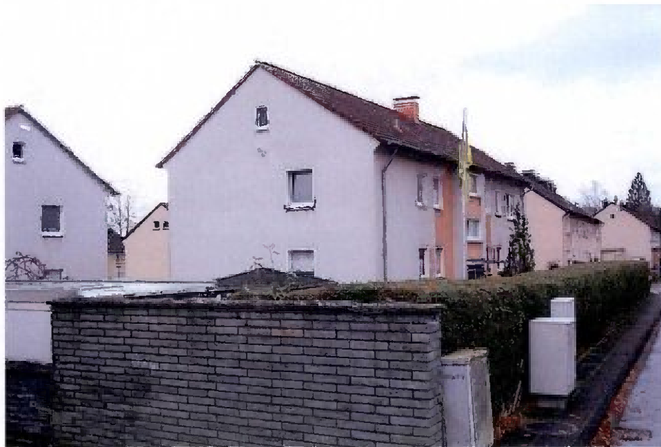
Bild 6: Straßenansicht Masurenstraße 11/ Südostgiebel / Nordostansicht
