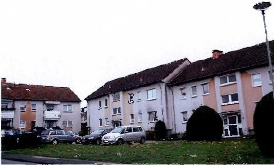
Bild 11: Straßenansicht Masurenstraße 11, 13 und 15
