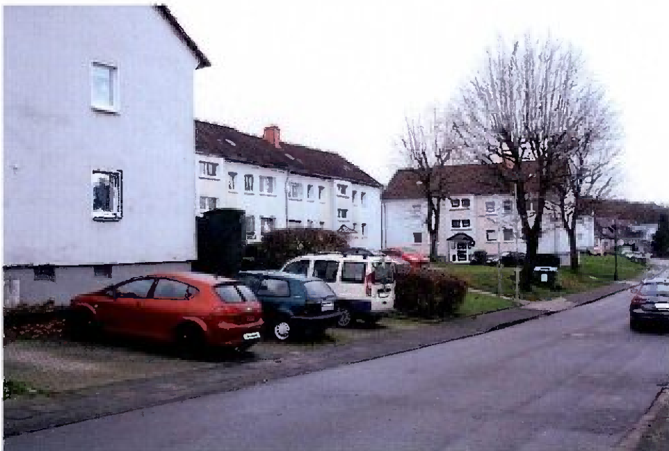
Bild 12: Straßenansicht Masurenstraße 17, 19, 21 und 23
