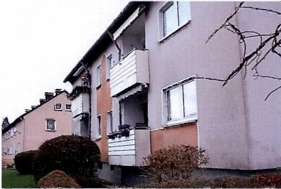
Bild 9: Südwestansicht des Gebäudes
