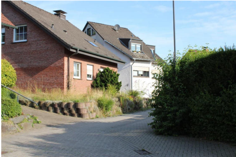
Bild 3: Umgebungsbebauung Richtung Norden
