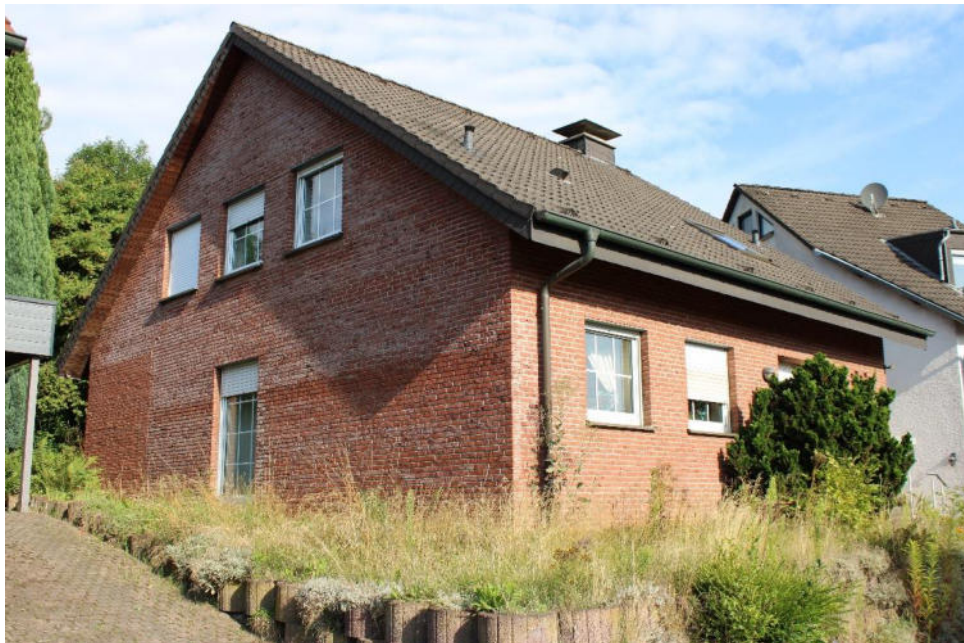
Bild 4: Straßenansicht / Südgiebel und Ostansicht
