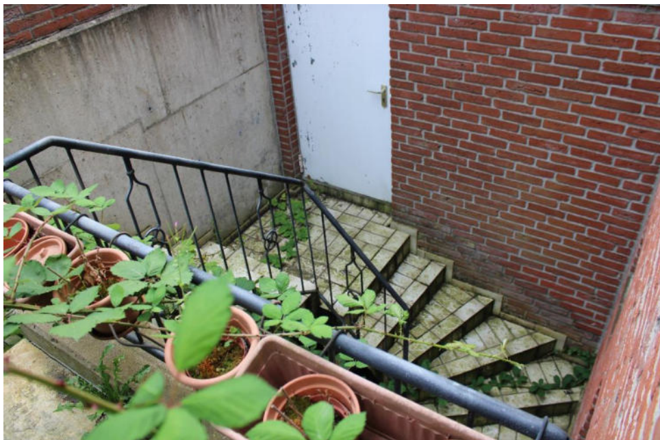
Bild 10: Kelleraußentreppe mit Zugang zur Garage
