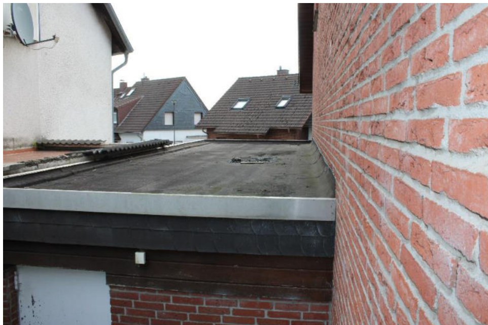
Bild 12: Rücksansicht Garage / Detail Garagendach/ Nordgiebel
