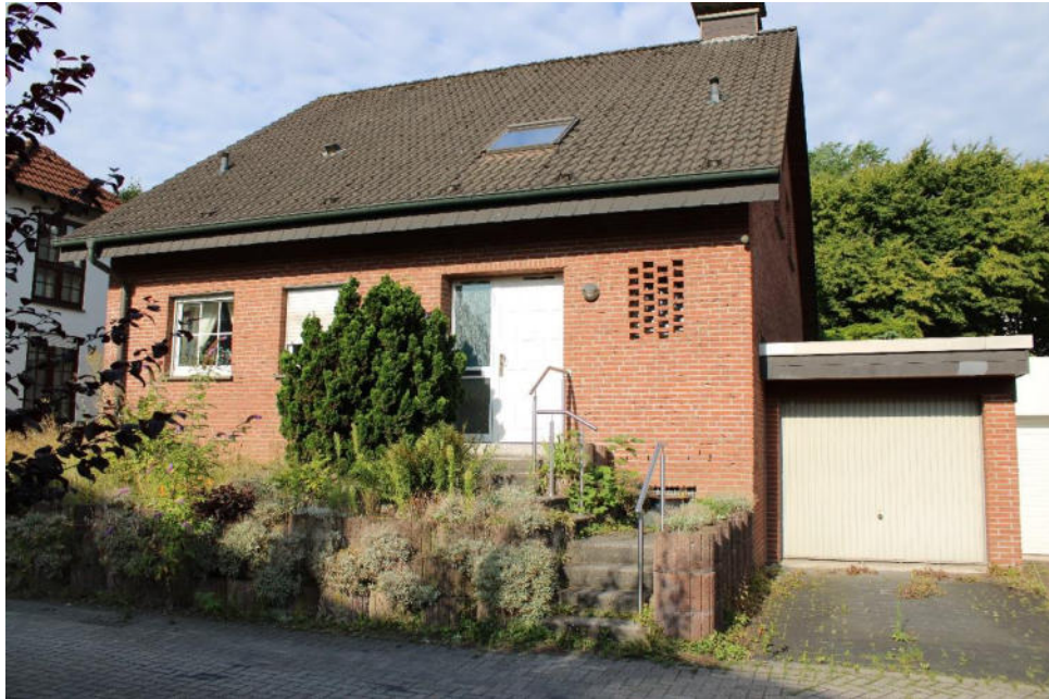
Bild 5: Straßenansicht / Ostansicht des Gebäudes und der Garage
