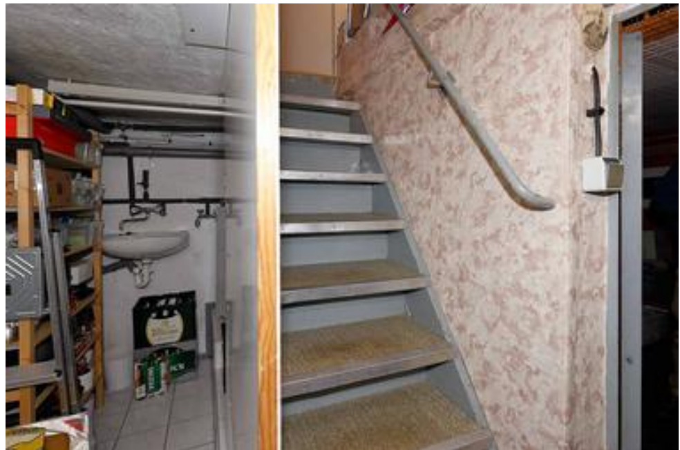
Foto Nr. 11 KG: Treppe zum Erdgeschoss
