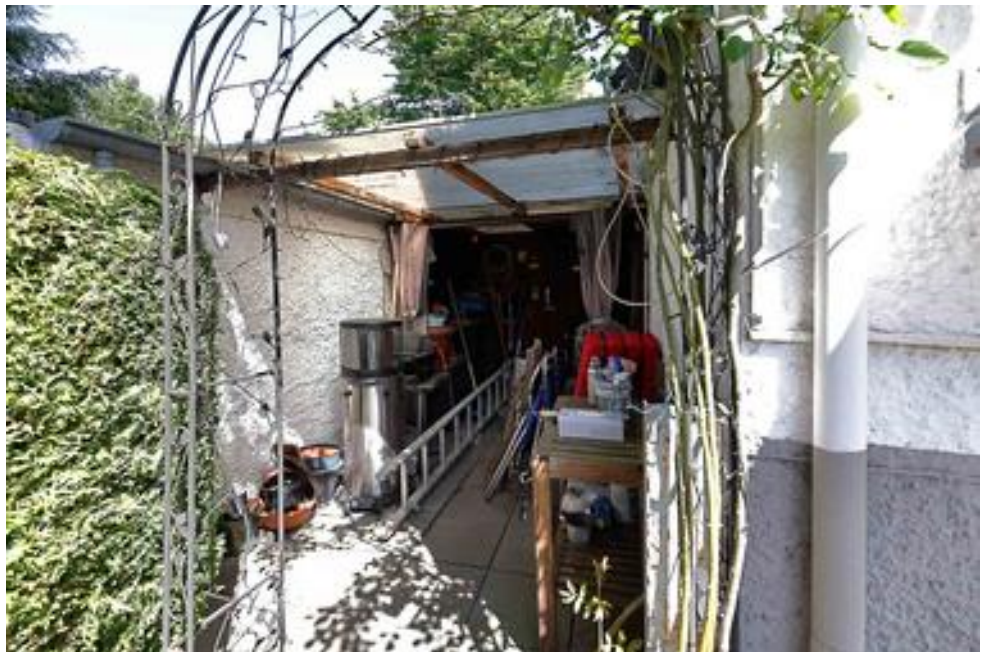
Foto Nr. 7 Terrasse mit Überdachung an der Nordgrenze
