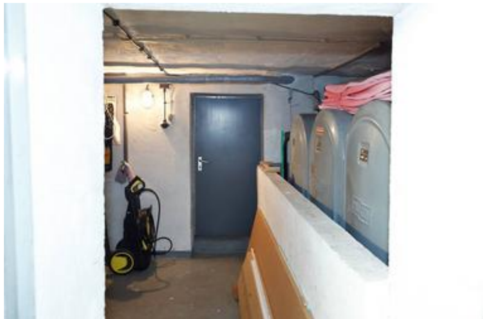
Foto Nr. 10 KG: Tankraum
