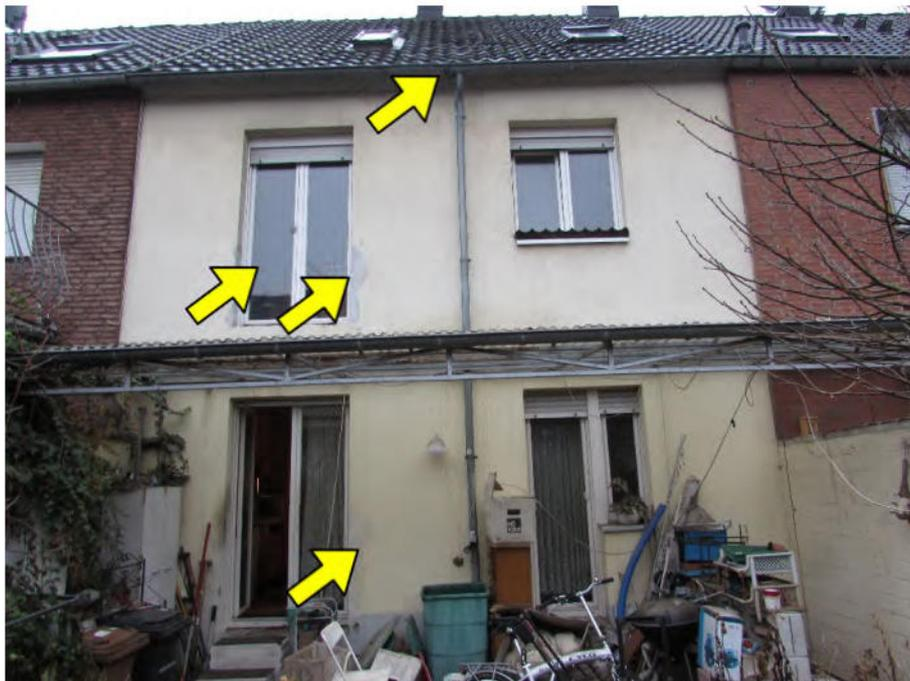
Foto 4: Wohnhaus, rückwärtige Ansicht: undichte Dachrinne, nicht ordnungsgemäß beigearbeitete Fensterlaibungen, fehlende Absturzsicherung
