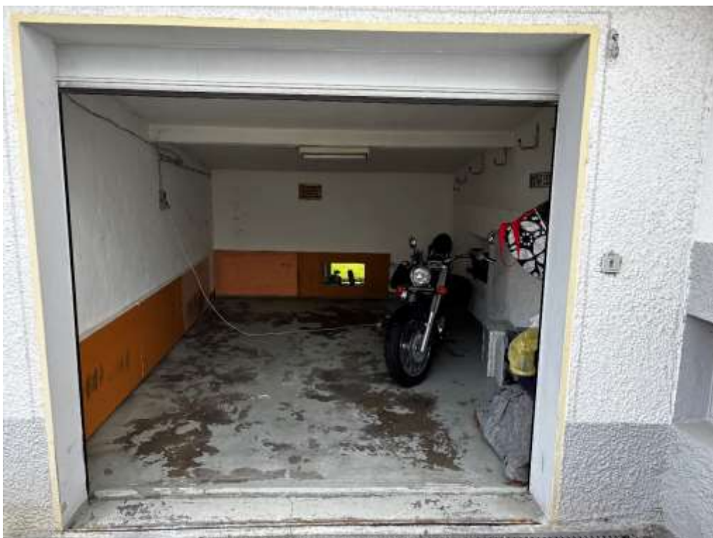
östliche Garage innen
