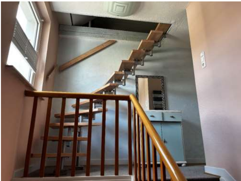
Treppe zum Spitzboden
