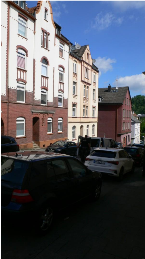
Bild 1: Breddestraße, Blick nach Norden
