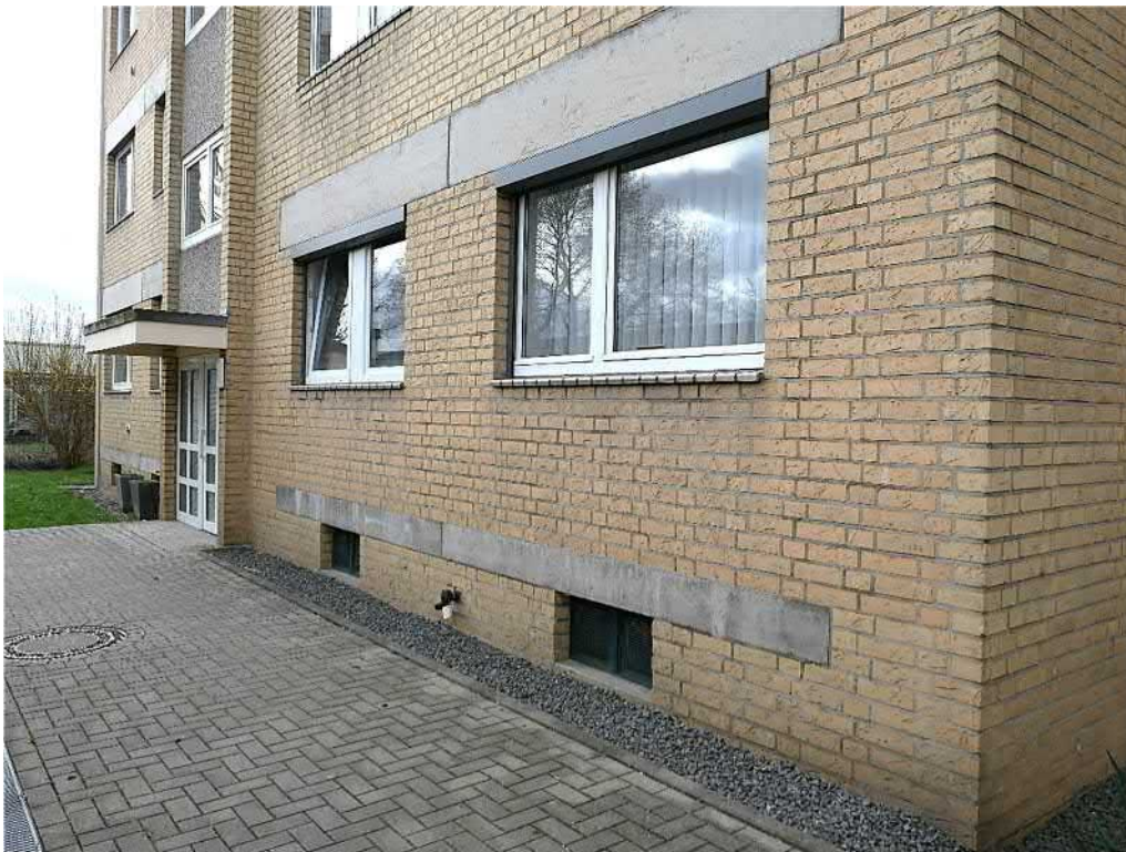
Ansicht Hauseingang Theodor-Heuss-Straße 1
