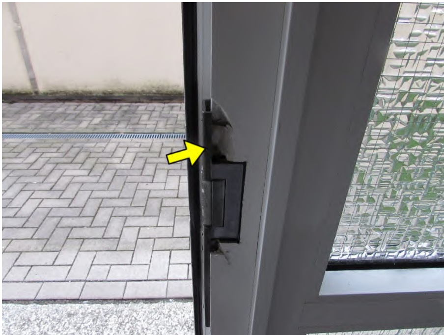
Foto 8: beschädigtes Hauseingangstürelement
