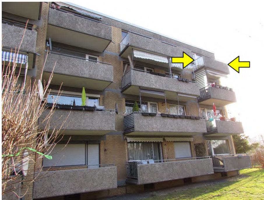
Foto 6: Trakt "Theodor-Heuss-Straße 1", Eigentumswohnung Nr. 44
