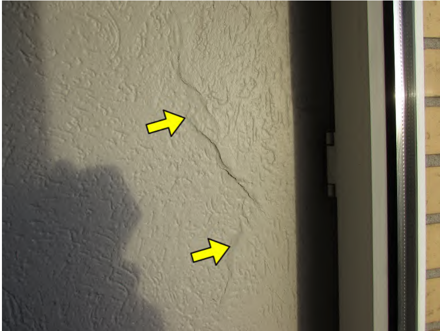
Foto 9: Treppenhaus: Putzschäden
