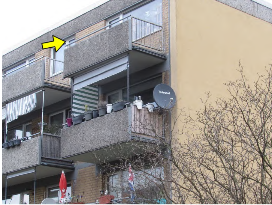
Foto 5: Trakt "Theodor-Heuss-Straße 1", Eigentumswohnung Nr. 44
