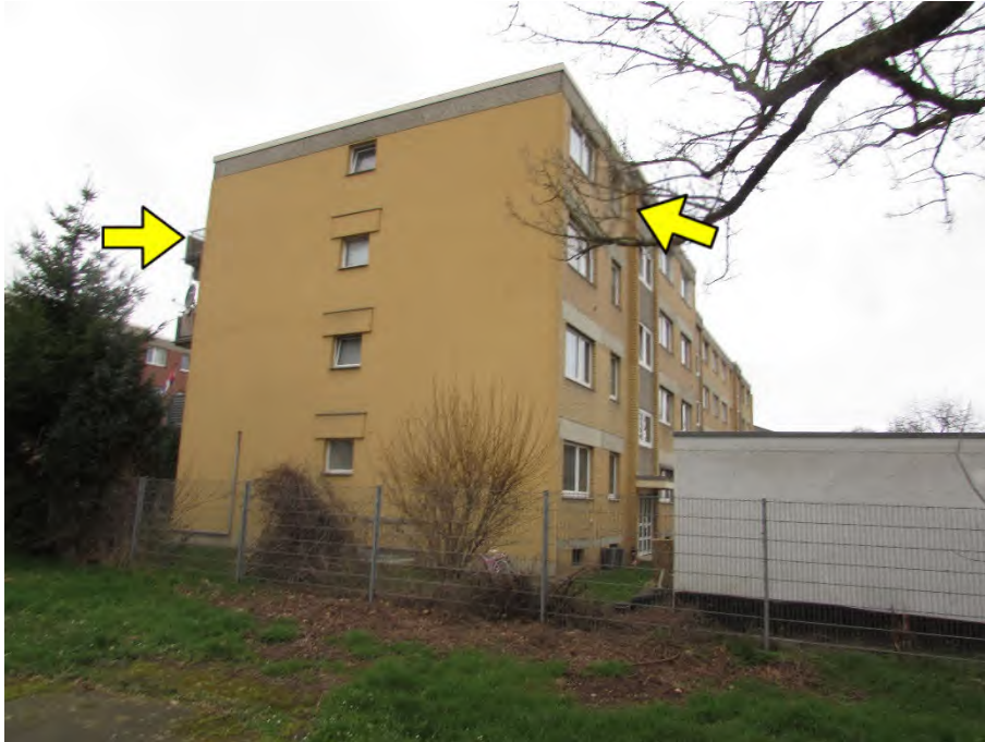
Foto 3: Trakt "Theodor-Heuss-Straße 1", Eigentumswohnung Nr. 44
