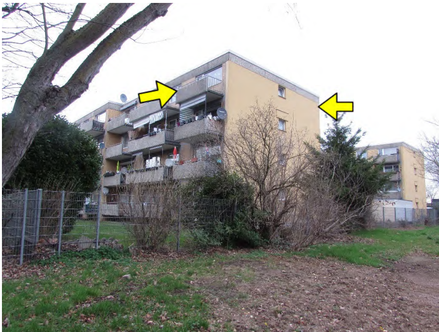
Foto 4: Trakt "Theodor-Heuss-Straße 1", Eigentumswohnung Nr. 44
