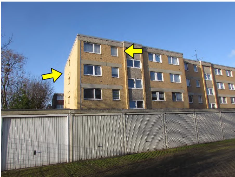
Foto 2: Trakt "Theodor-Heuss-Straße 1", Eigentumswohnung Nr. 44
