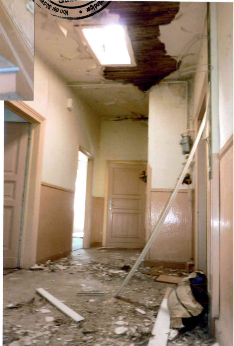
Bild 43 und 44 Dachgeschossflur mit erheblichen Feuchteschäden an Deckenunter- sichten
