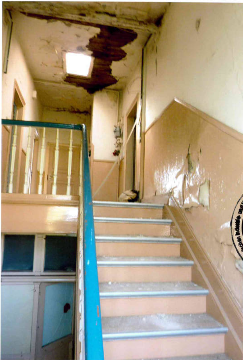
Bild 43 und 44 Dachgeschossflur mit erheblichen Feuchteschäden an Deckenunter- sichten
