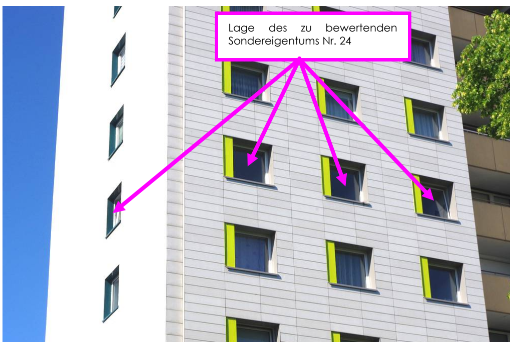
Bild 2: wie vor, Detailansicht
