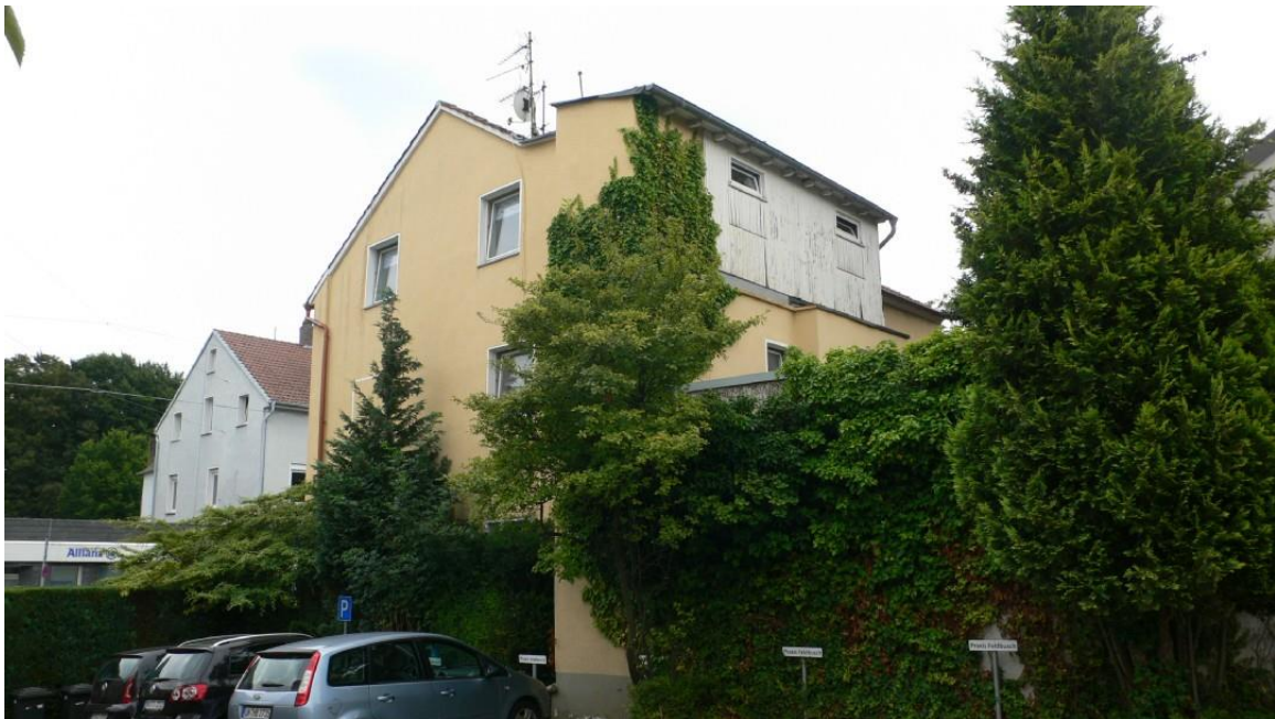
Bild 14: Ansicht von Nord-West
