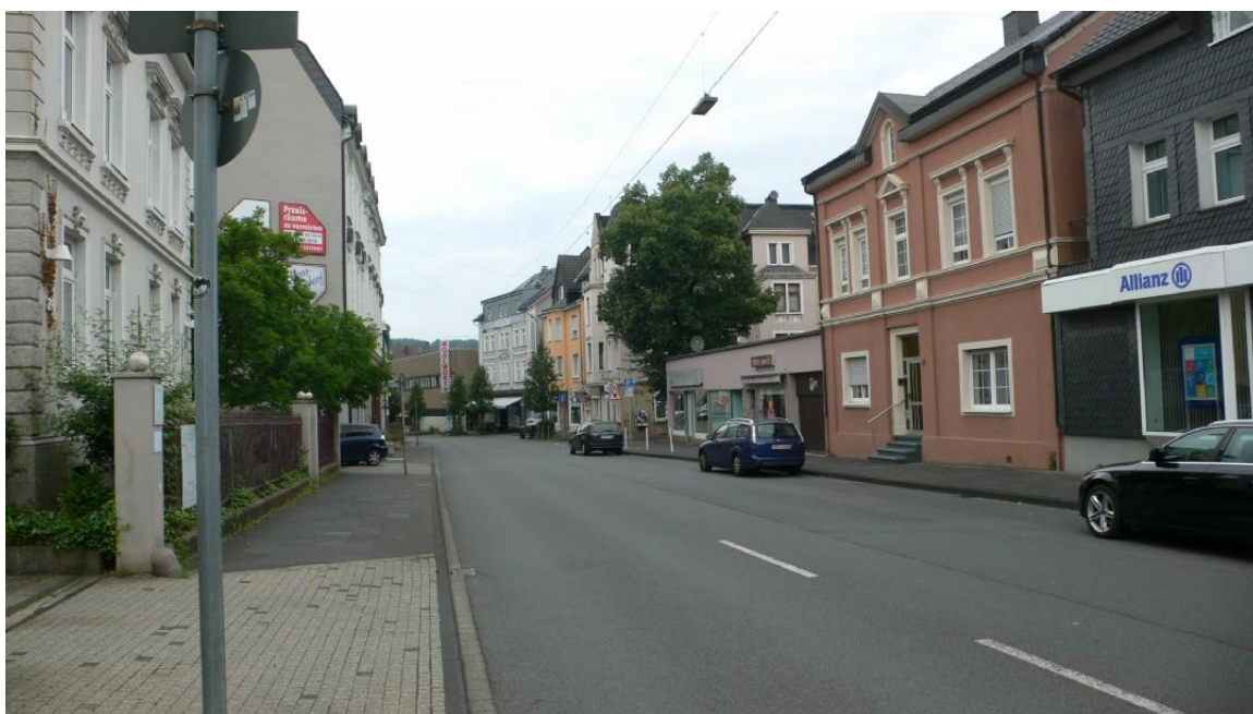
Bild 11: Voerder Straße, Blick nach Norden
