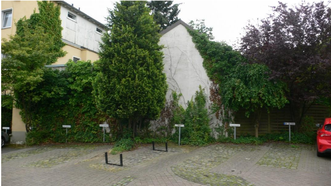
Bild 15: Grenzwand und Hofanbau von Norden
