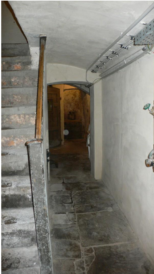
Bild 26: Treppe ins EG
