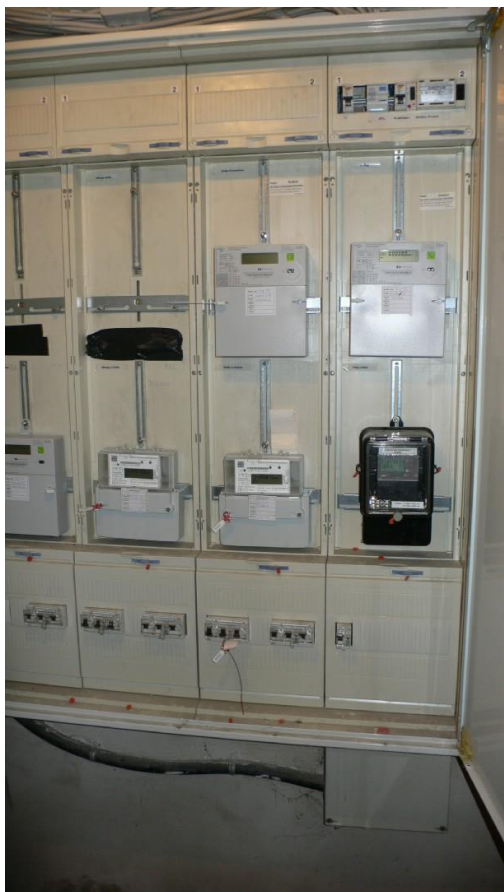
Bild 22: Zählerkasten im KG
