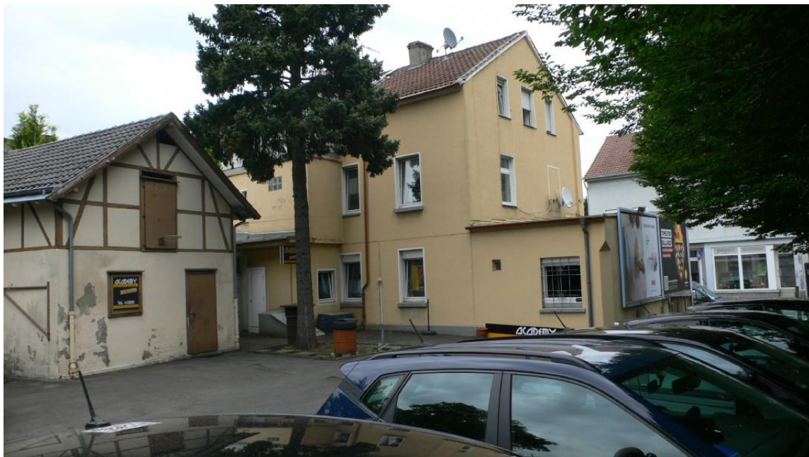
Bild 1: Hofansicht von Süd-Westen
