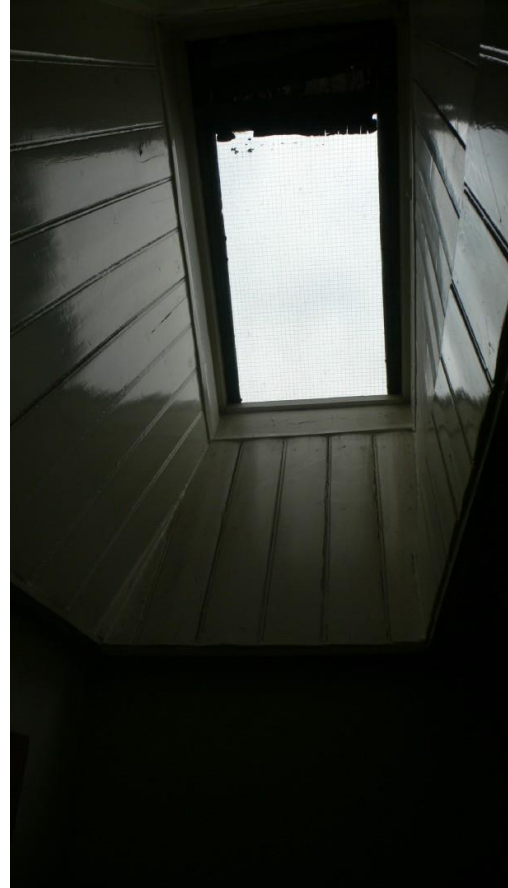
Bild 31: Dachfenster im DG
