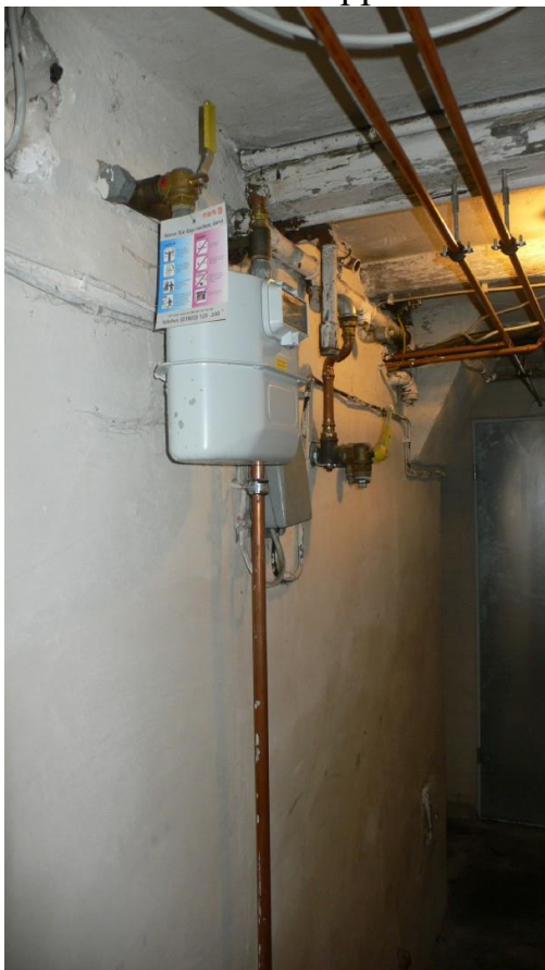
Bild 28: Gaszähler im KG
