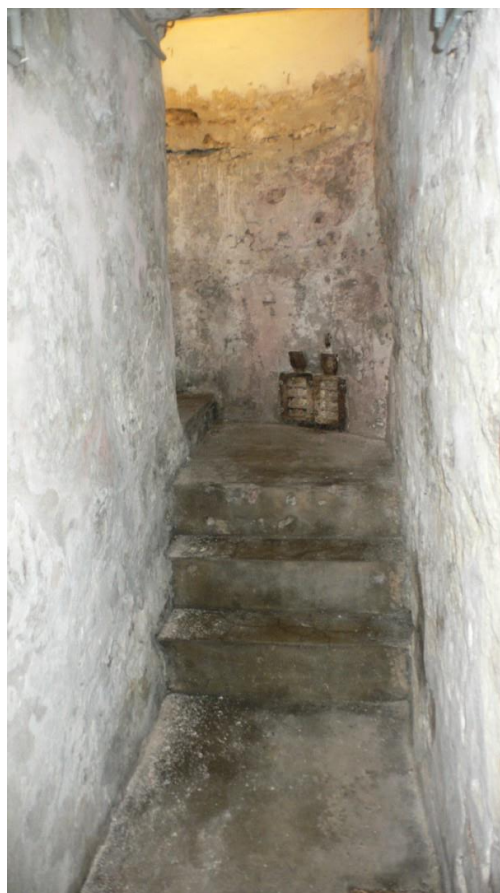
Bild 25: Treppe zu Hof
