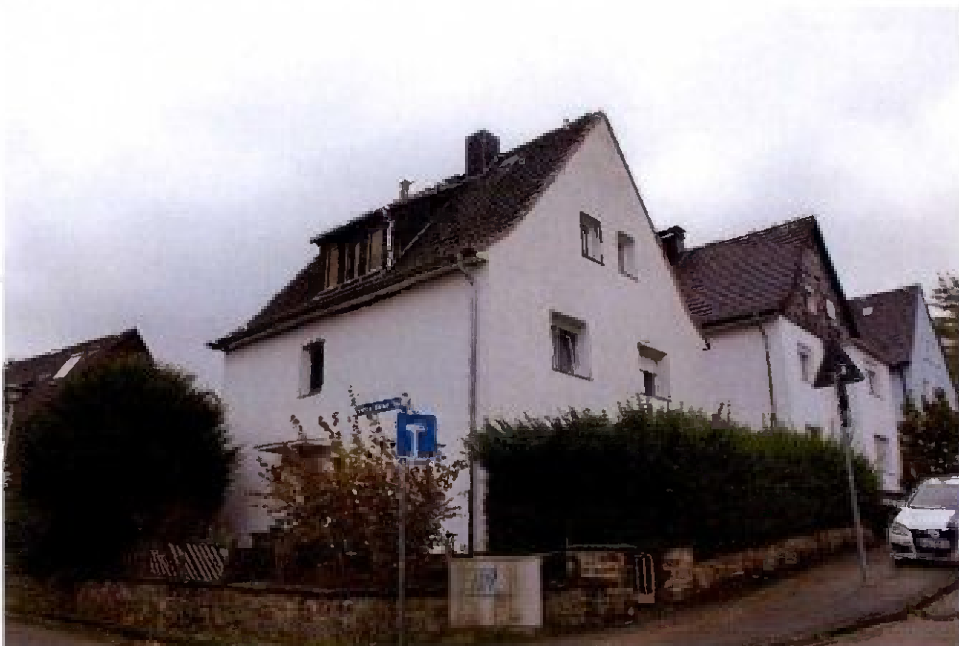
Bild 6: Straßenansicht/Nordwestansicht und Südwestgiebel
