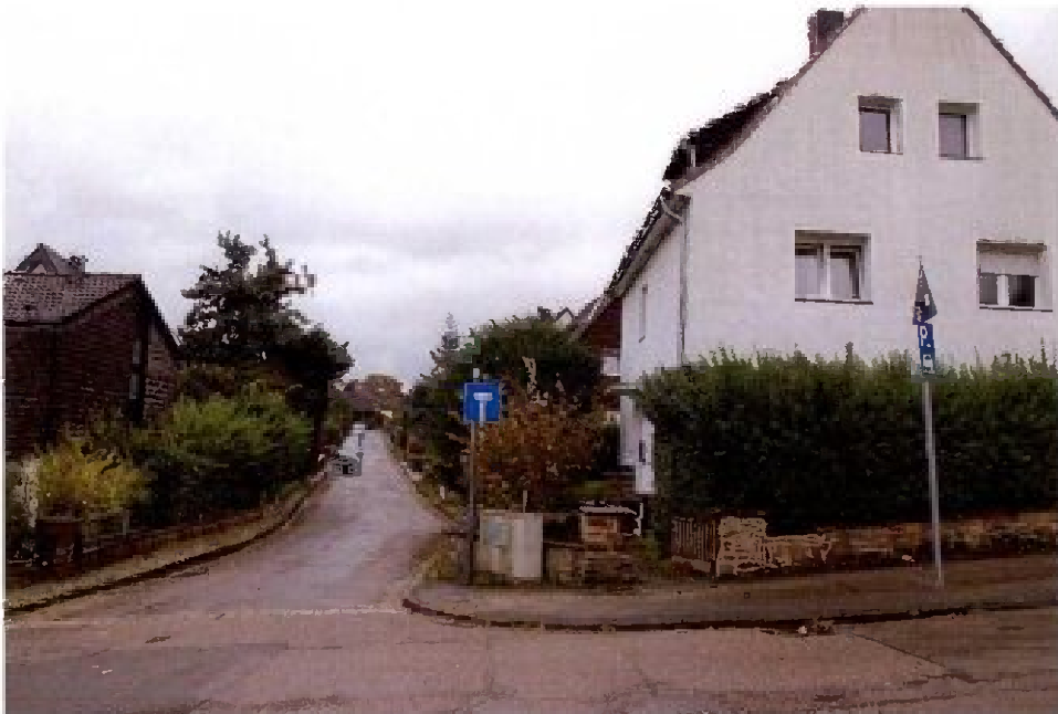
Bild 4: Südwestgiebel und Nordwestseite
