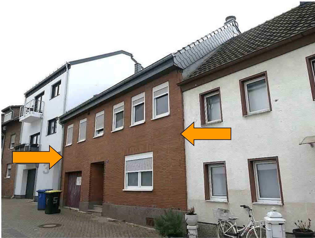
Straßenansicht von Westen
