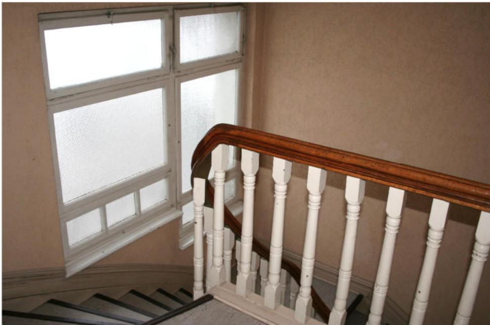
Bild 18: Treppenhaus / einfachverglaste Treppenhausfenster
