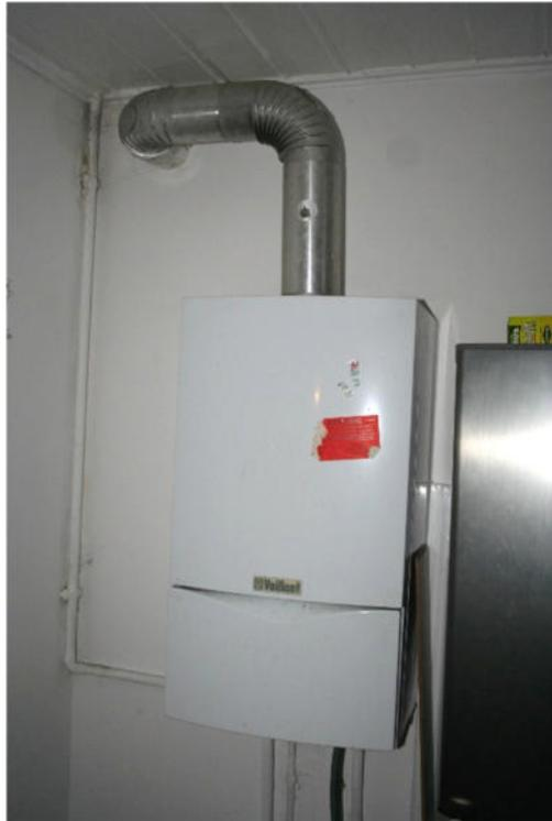
Bild 31: Gaskombitherme zur Heiz- und Warmwasserversorgung der Wohnung
