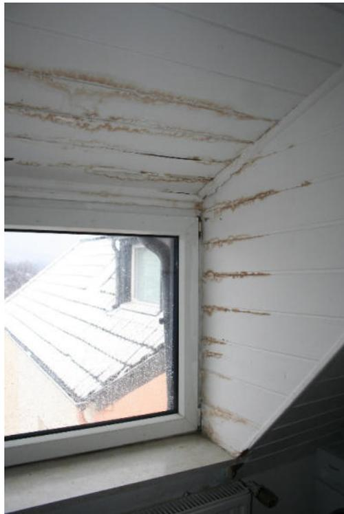
Bild 30: Feuchtigkeitseinwirkungen im Dachgaubenbereich der Küche
