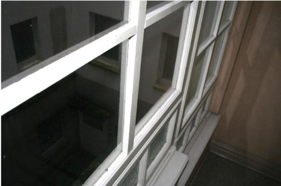
Bild 21: einfachverglastes Treppenhausfenster
