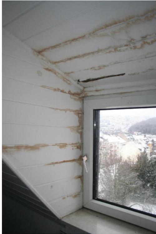
Bild 29: Feuchtigkeitseinwirkungen im Dachgaubenbereich der Küche
