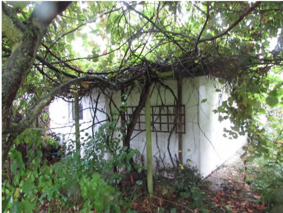
Foto 13: Doppelgarage, rückwärtige Ansicht
