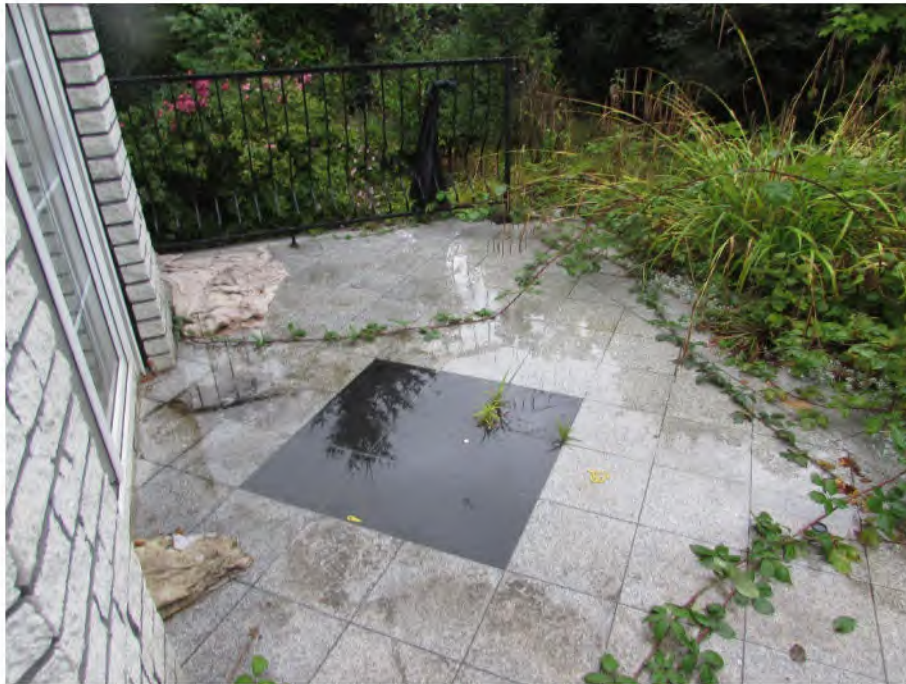
Foto 9: Wohnung 1, Erdgeschoss, (Dach-)Terrasse 2
