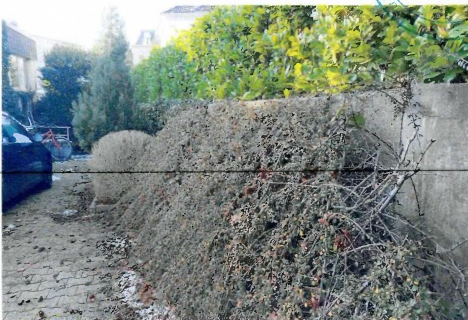
Foto Nr. 4 Stützmauer entlang der nördlichen Grundstücksgrenze
