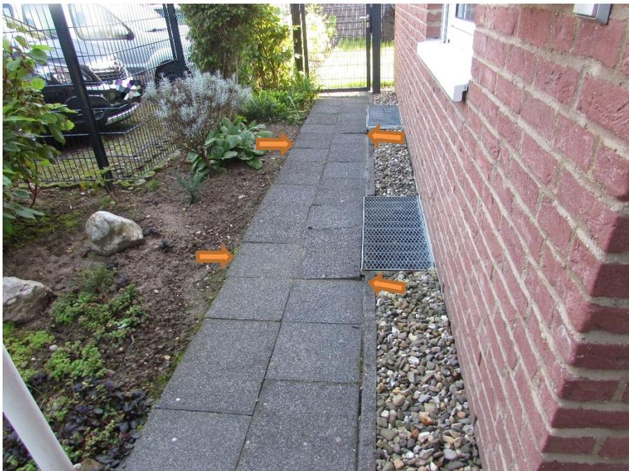
Foto 10: Wohnhaus, Umgang, abgesetzte Betonplatten
