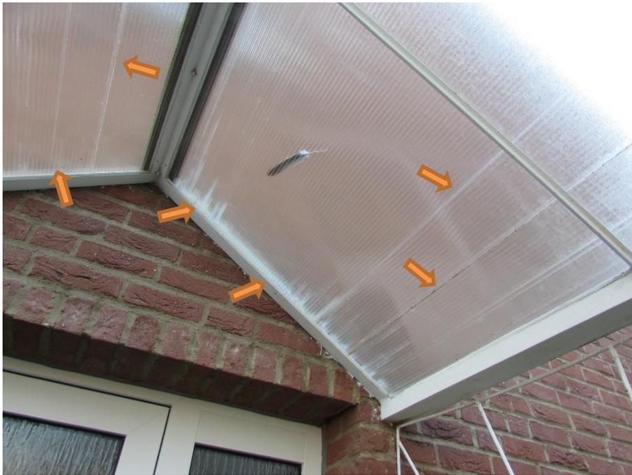
Foto 11: Wohnhaus, beschädigte Doppelstegeplatten der Hauseingangsüberdachung
