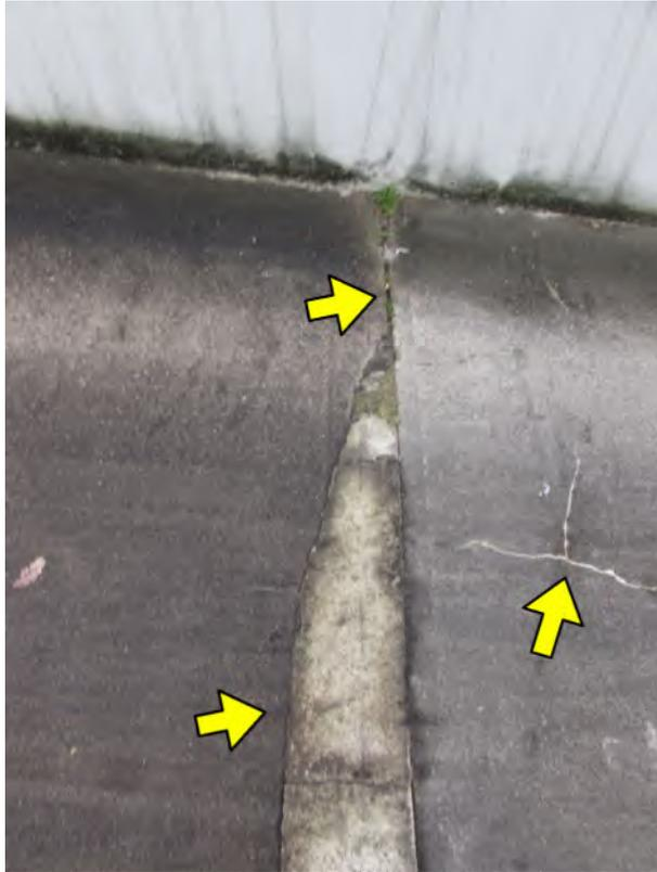
Foto 13: Zufahrtsrampe zur Tiefgarage: schadhafter Beton
