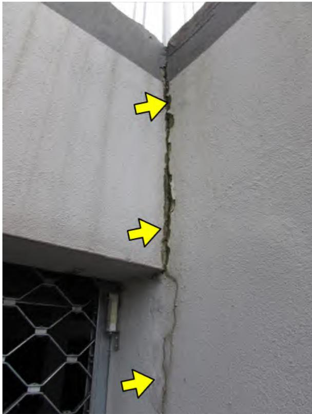
Foto 12: Tiefgarage: Rissbildung im Anschlussbereich der Stützwand
