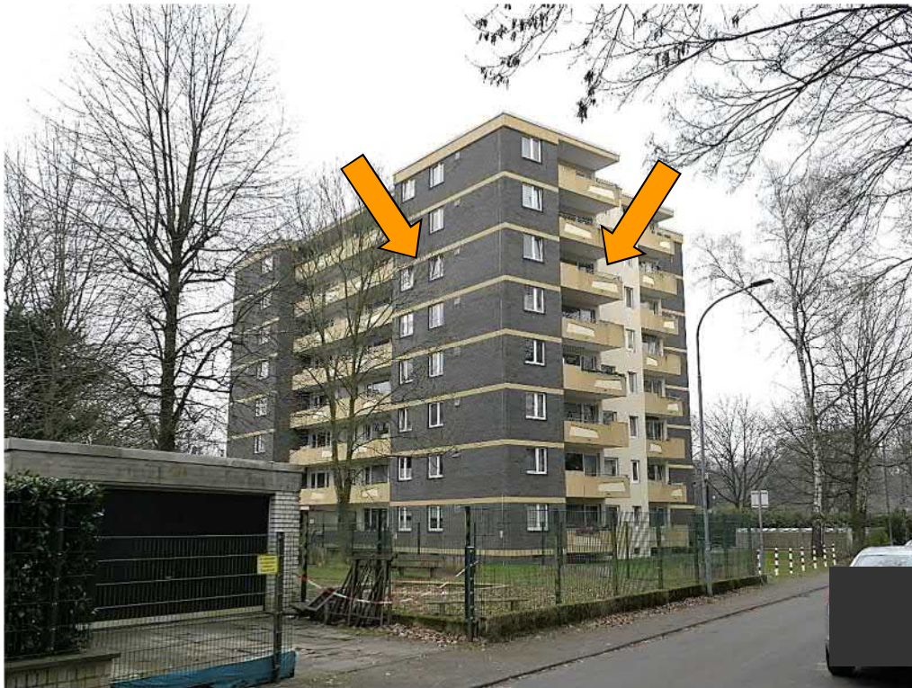
Straßenansicht von Nordwesten (von der Straße „Weißer Weg“)
