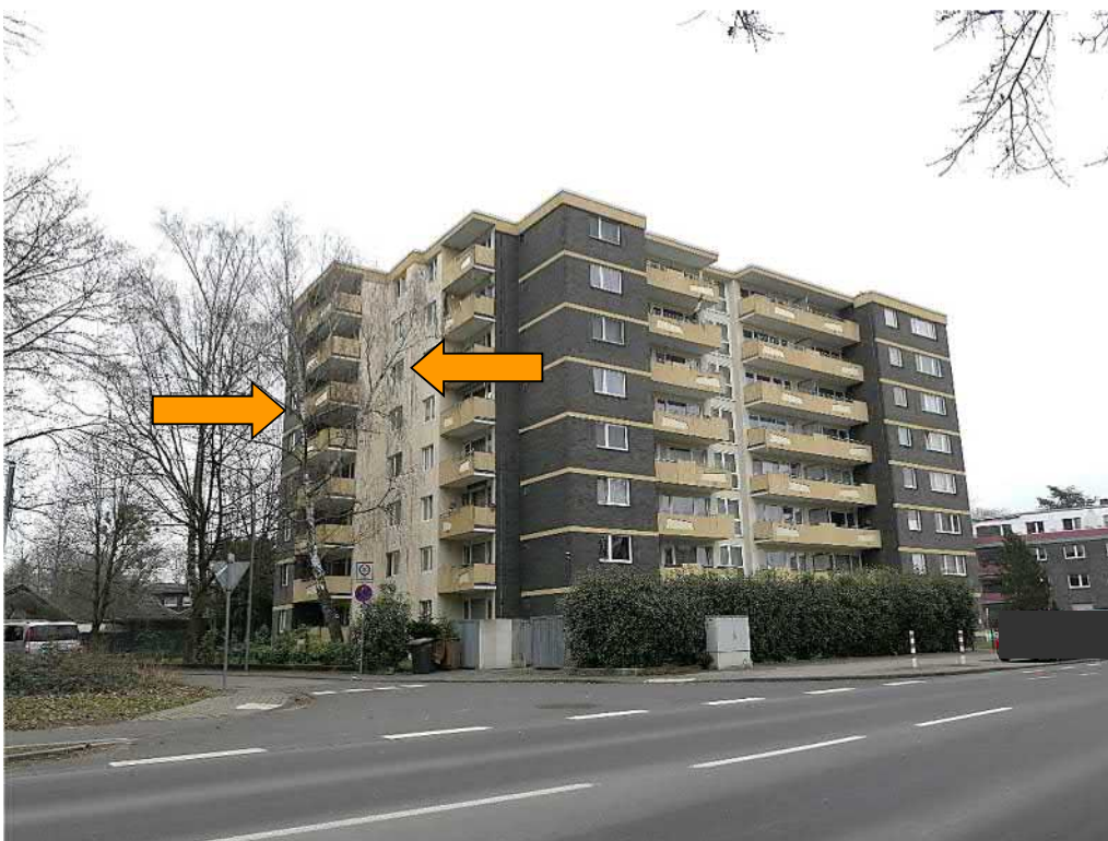
Straßenansicht von Südwesten (von der Rathausstraße)
