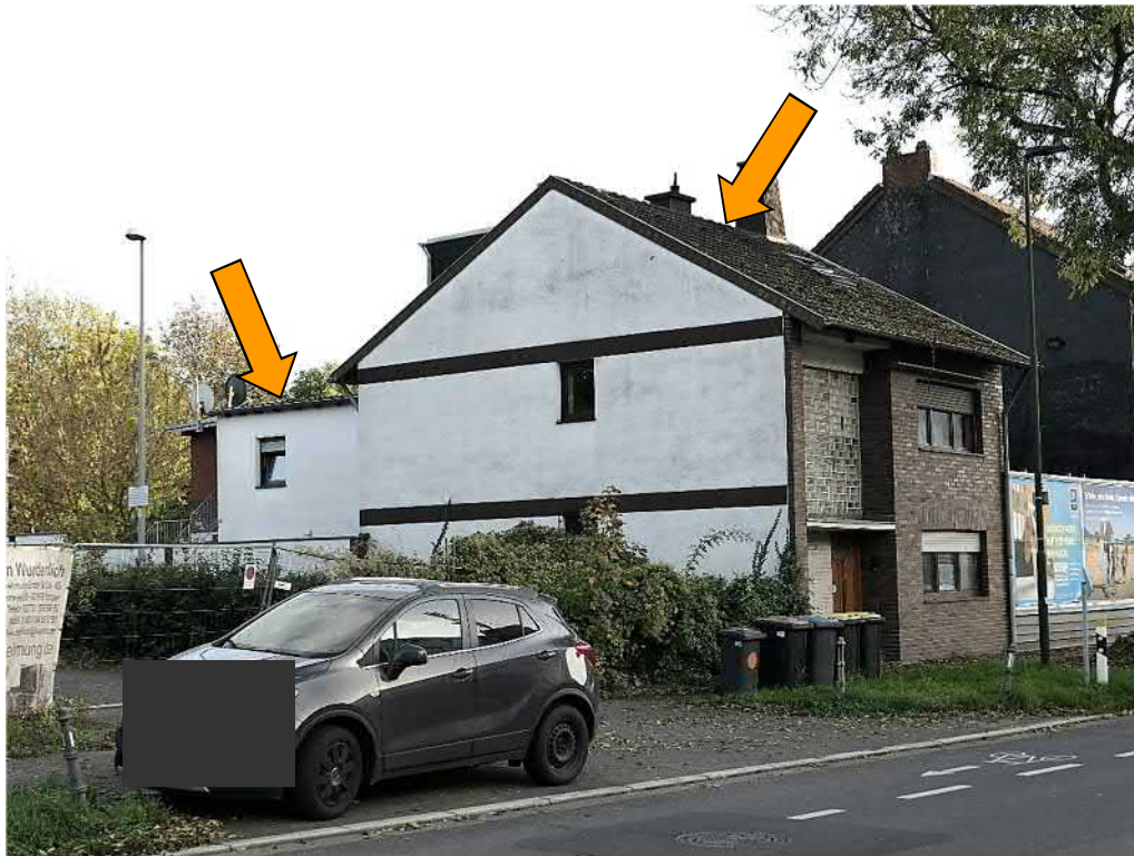
Straßenansicht von Nordwesten
