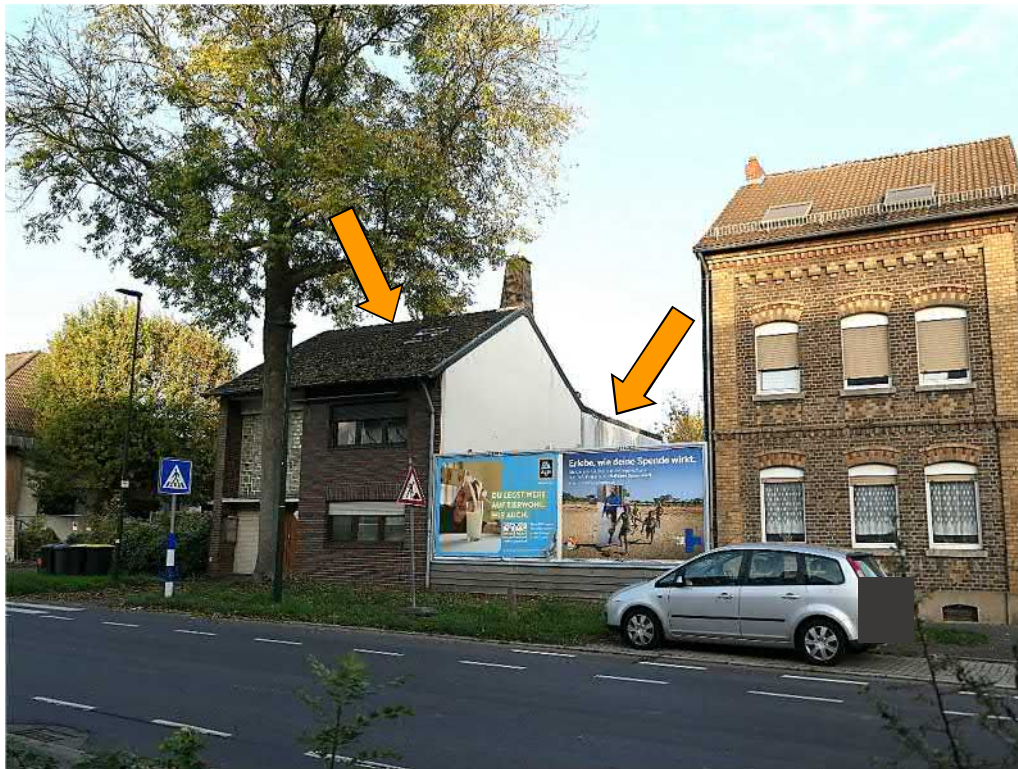
Straßenansicht von Südwesten
