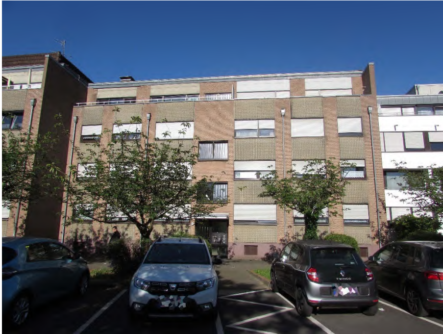
Foto 1: Mehrfamilienhaus "Mittelstraße 44", 50169 Kerpen-Horrem, Straßen-Ansicht
