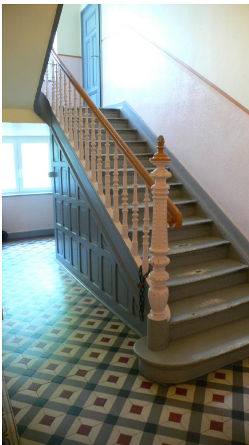
Bild 21: Treppe ins OG
