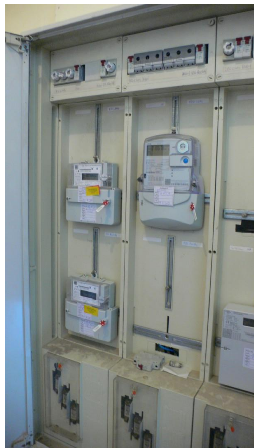
Bild 22: Stromkasten EG
