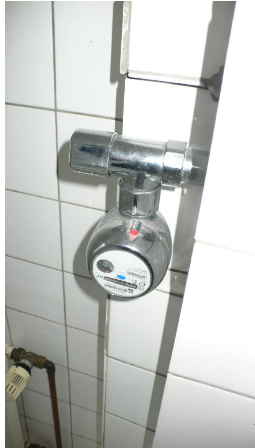
Bild 32: Wasserzähler
