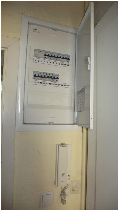
Bild 37: Elektrounterverteilung
