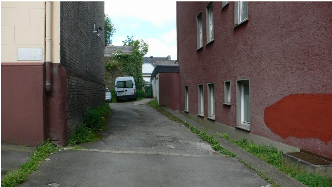
Bild 8: Zufahrt zum Hof, Blick nach Westen
