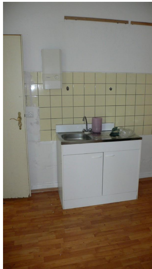
Bild 34: Küche mit Installation
