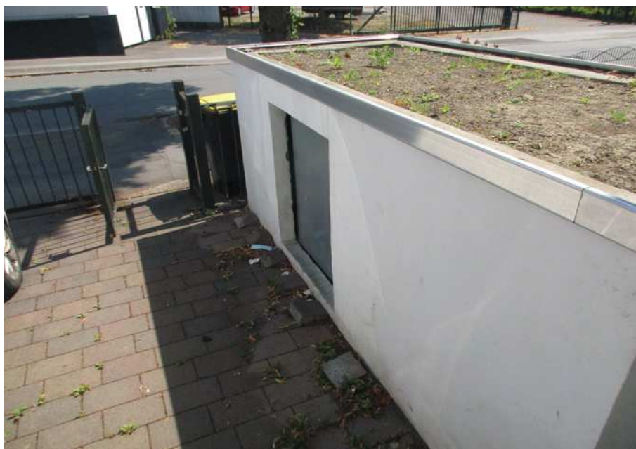
Foto 9 Abstellraum im Südosten
