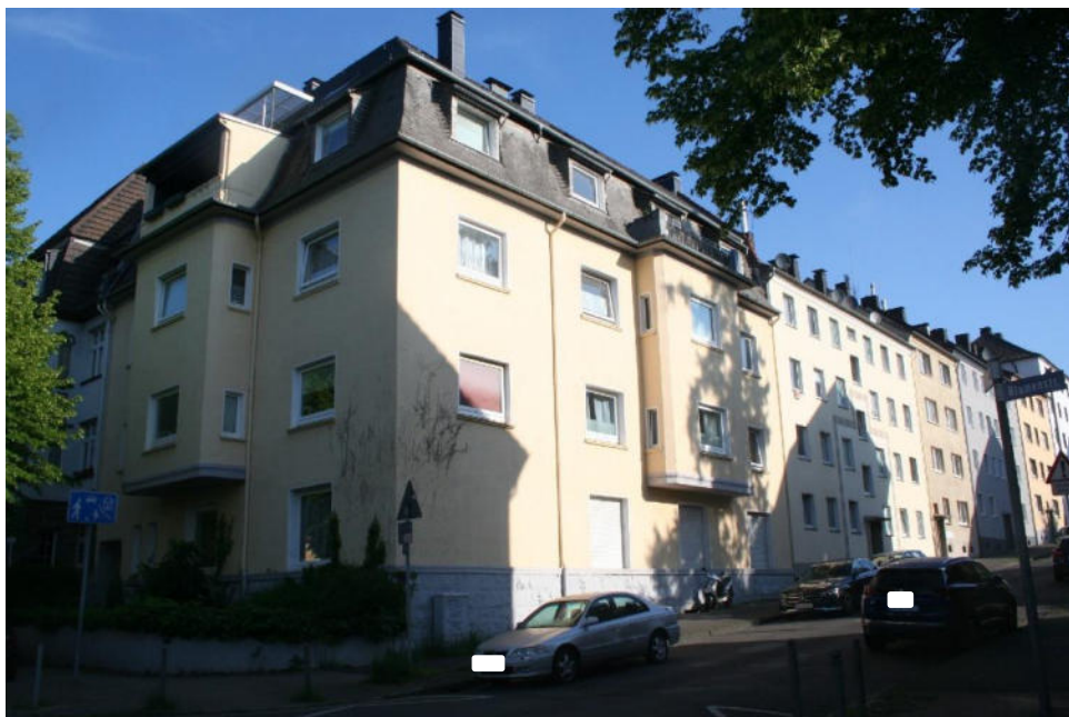
Bild 4: Straßenansicht / Südwestansicht Blumenstraße und Südostansicht Königstraße
