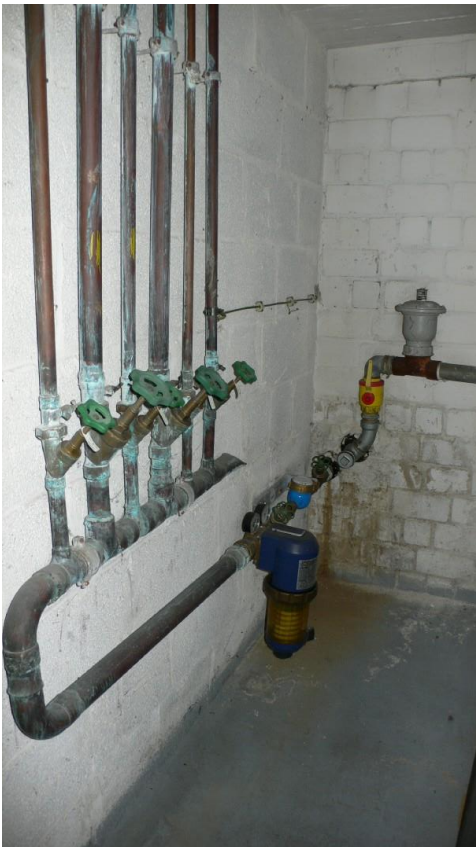
Bild 16: Hausanschluss Wasser
