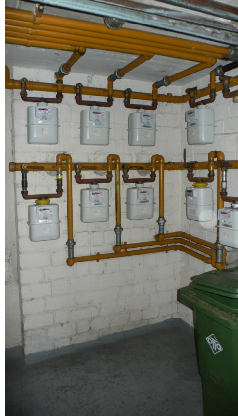
Bild 15: Gaszähler im KG
