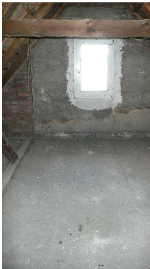
Bild 36 + 37: Dachstuhl und Giebfenster
