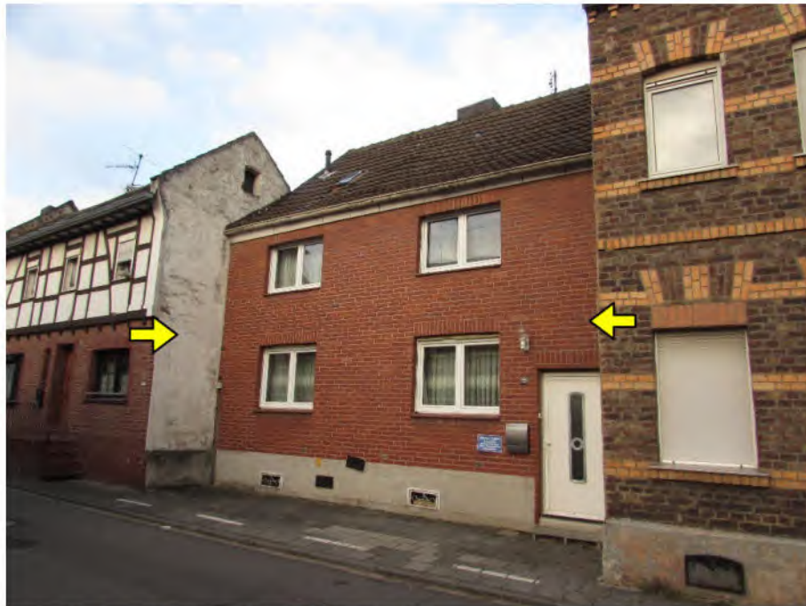
Foto 1: Ansicht von der "Mähnsstraße"
