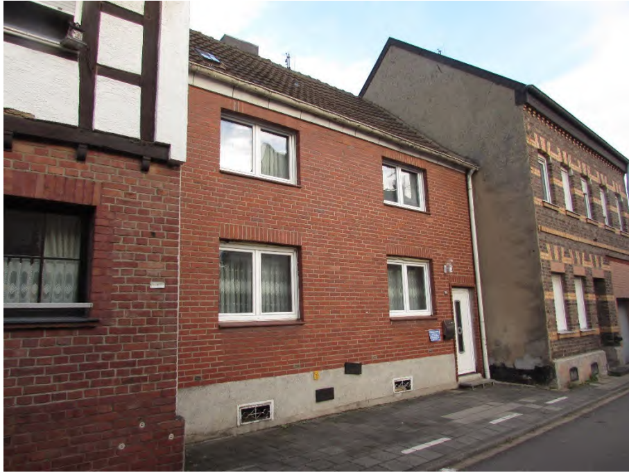
Foto 3: Ansicht von der "Mähnsstraße"
