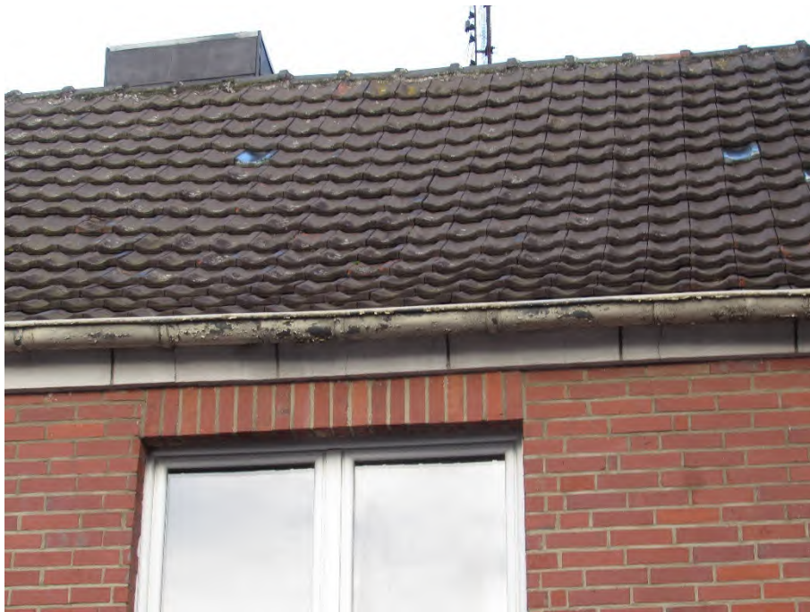
Foto 11: Zustand Dachstuhl, Dacheindeckung sowie Dachentwässerung
