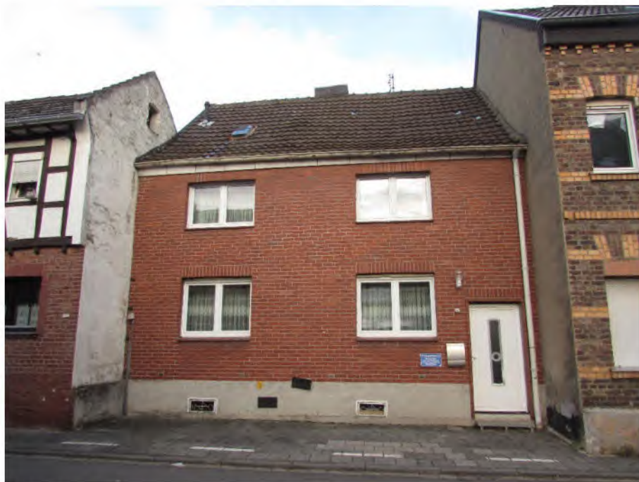
Foto 2: Ansicht von der "Mähnsstraße"
