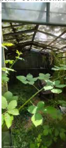
Blick in das ehem. Gewächshauses, Flurstück 220
