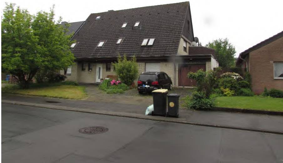
Foto 1: Wohnhaus mit (nach einem Brand) baufälliger PKW-Doppelgarage "Hohlweg XX", 50170 Kerpen-Buir
