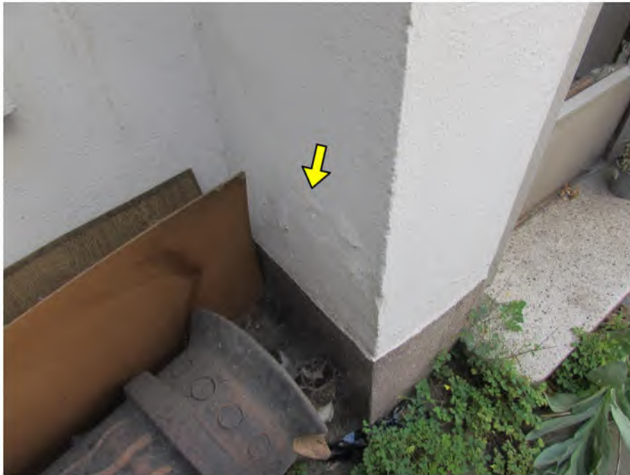
Foto 5: Fassadenputz: Feuchtigkeit
