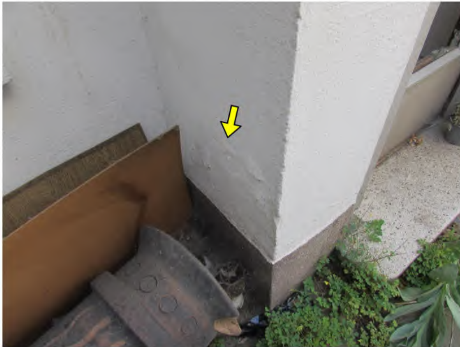
Foto 5: Fassadenputz: Feuchtigkeit
