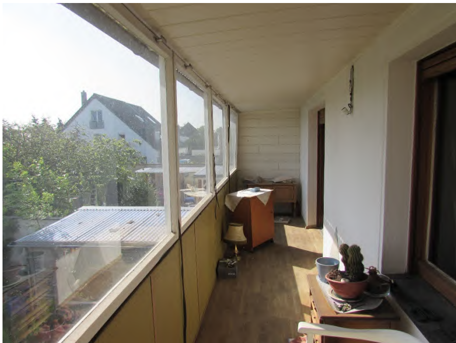
Foto 28: Obegeschoss, baulich geschlossener Balkon
