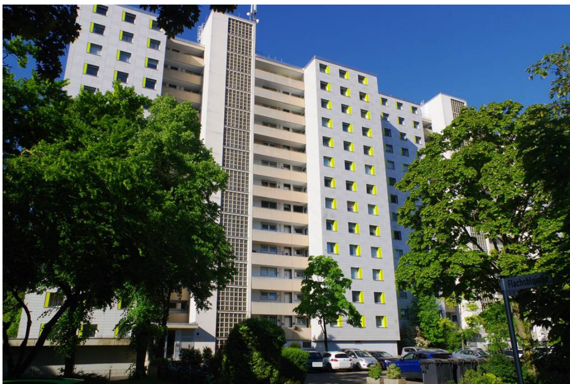
Bild 4: Straßenansicht der aufstehenden Wohnhausbebauung auf dem Grundstück
