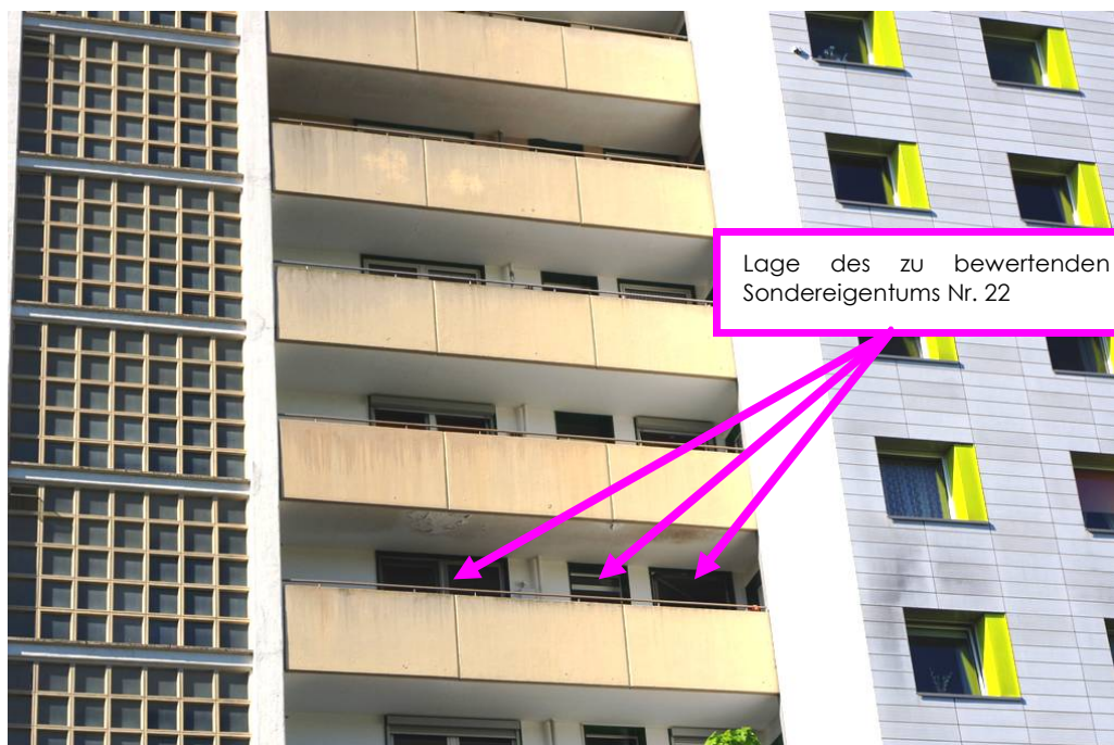
Bild 2: wie vor, Detailansicht
