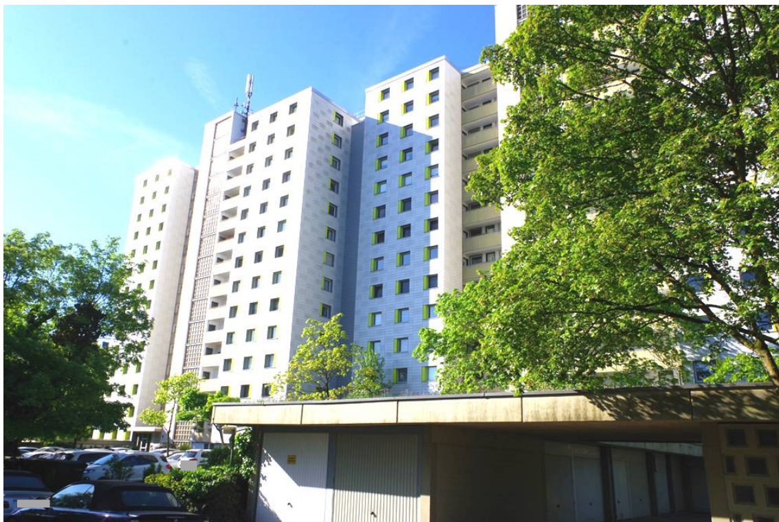
Bild 4: straßenseitige Übersichtsaufnahme des Gebäudekomplexes Flachsbleiche 70, 72
