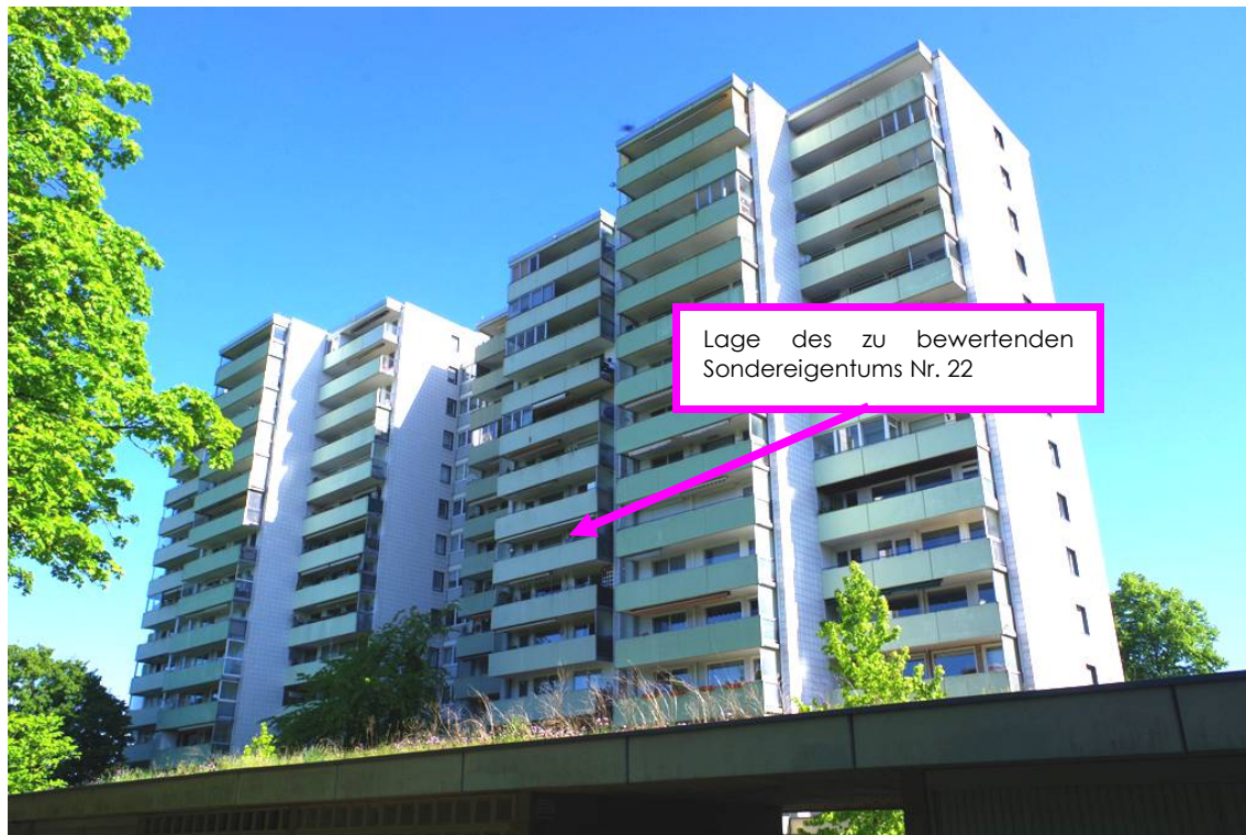
Bild 3: Rückansicht des Gebäudekomplexes aus Süd
