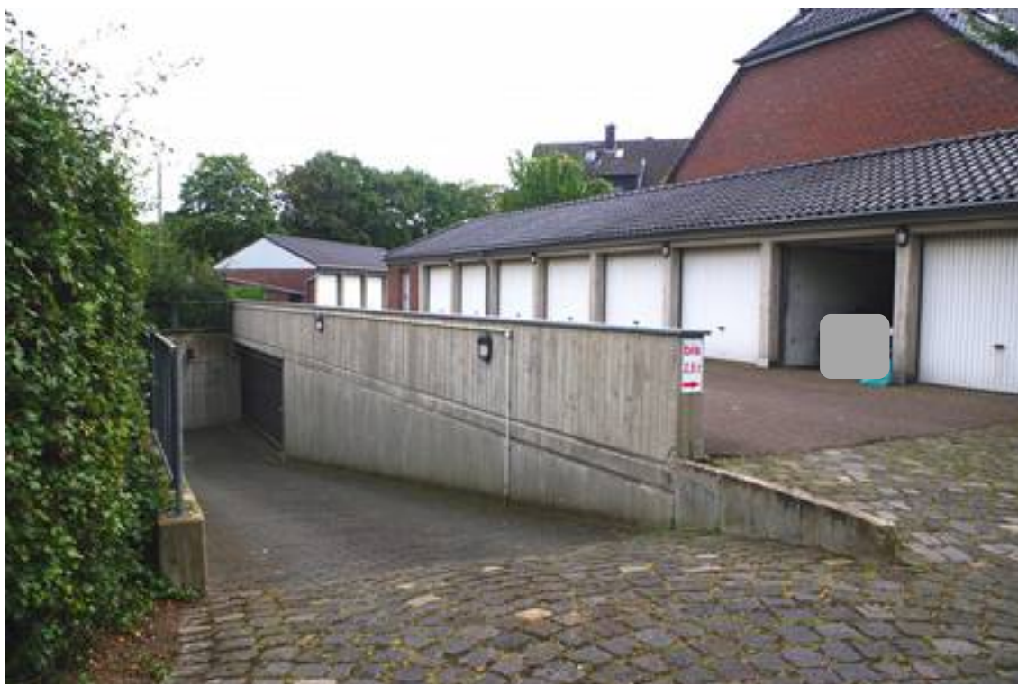
Bild 4: Übersichtsaufnahme der Reihengaragen sowie Ansicht der Tiefgaragenzufahrt
