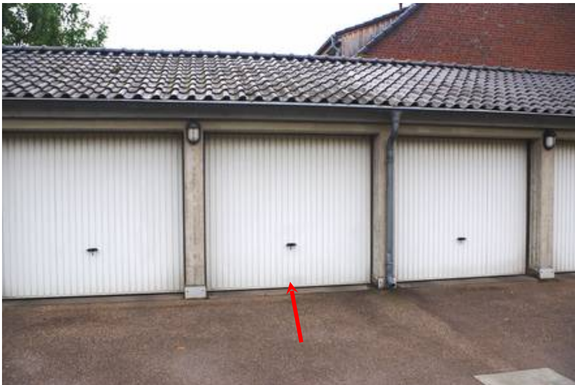
Bild 2: Ansicht der Reihengaragen aus Nord sowie Kennzeichnung der zu bewertenden Reihengarage Nr. 46
