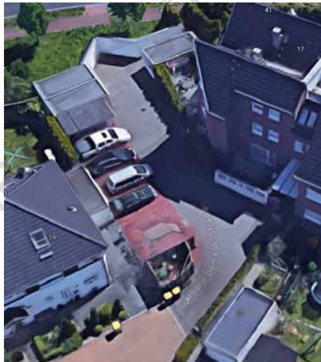
Ansicht von Westen, Quelle google maps
